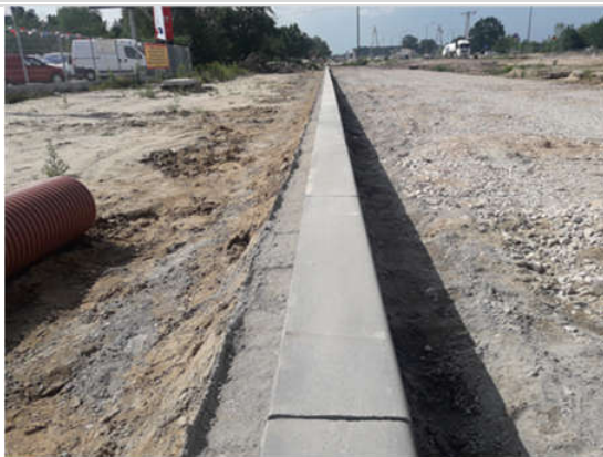
20.07.2018r execution of kerb ul. Ogórkowa bis 0+200 – 0+600
