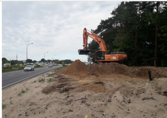
04.07.2018 soil stripping Wał Miedzeszyński km 0+000 – 0+180 SP
