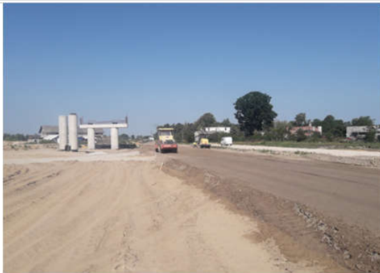
06.07.2018 embankment Ł2 km 0+100 – 0+220 layer1
