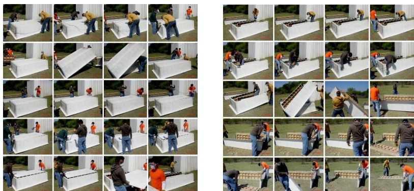
Figuras 114 y 115. Proceso constructivo del Módulo 10x10 con cerramiento de fibra de vidrio reciclada
