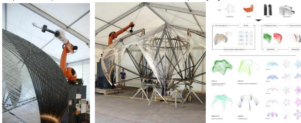
Figuras 43, 44 y 45. Proceso de construcción mediante brazo robotizado.
