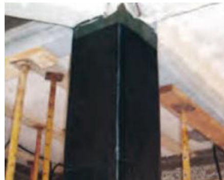
Figura 23. Refuerzo en soporte rectangular
