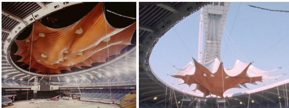
Figuras 65 y 66. Techo retráctil de kevlar en diferentes fases
