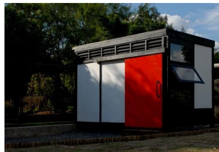
Figuras 112 y 113. Módulo 10x10 con cerramiento de fibra de vidrio reciclada
