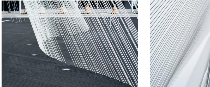
Figuras 35 y 36. Detalles de las fibras antisísmicas Cabkoma
