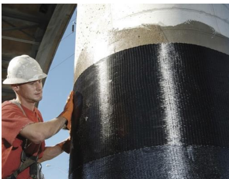
Figura 22. Refuerzo en soporte circular
