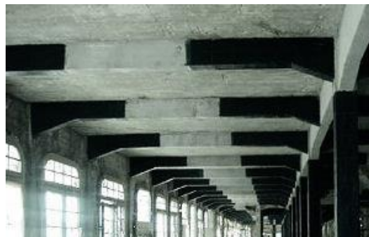
Figura 18. Refuerzos en caras laterales de vigas
