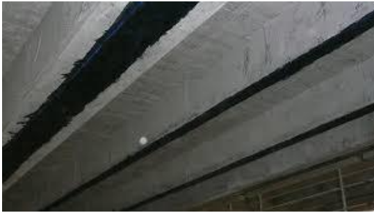
Figuras 16 y 17. Refuerzos en caras inferiores de vigas
