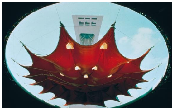
Figura 69. Techo retráctil en fase avanzada de estiramiento
