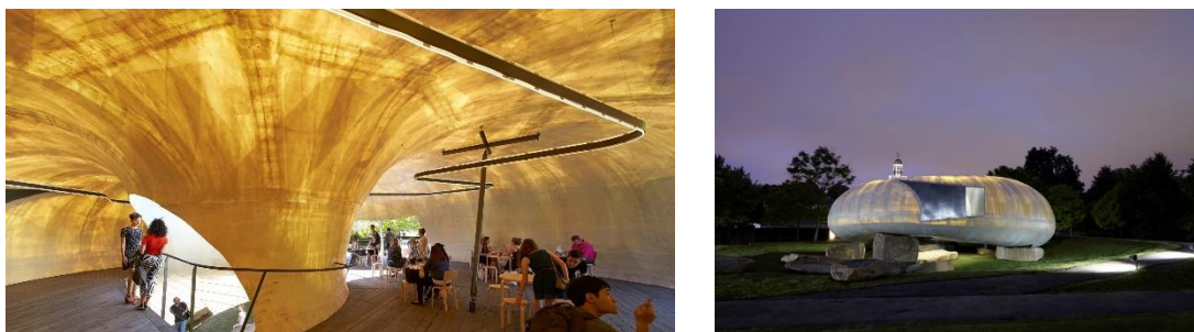
Figuras 122 y 123. Estructura translúcida de fibra de vidrio iluminada por la luz del sol o por luces artificiales
