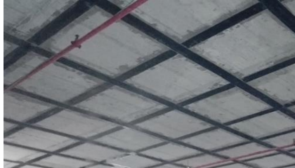
Figura 20. Refuerzos en caras inferiores de forjados
