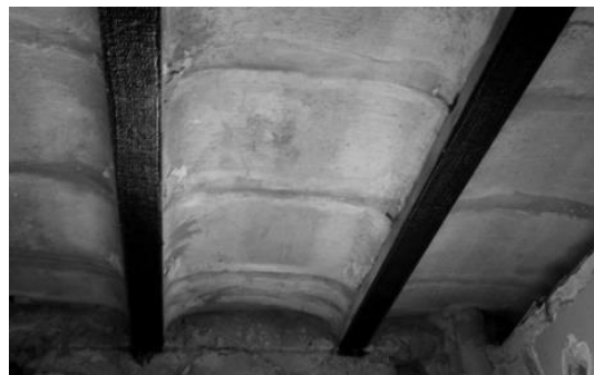
Figura 19. Refuerzos en caras inferiores de viguetas
