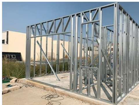
Figura 12. Sistema modular de acero
