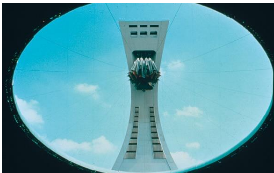
Figura 67. Techo retráctil en su posición recogida.
