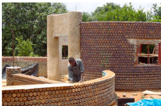
casas hechas con botella rellenas de arena en Nigeria. Asociación de Desarrollo de Energías Renovables (DARE).
