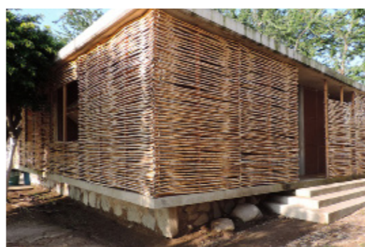
un edificio comunitario de muros de bahareque y celosía de carrizo. colectivo bma Guadalajara, México.
