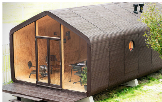
wikkelhouse, casas de cartón que se construyen en un día. Fabricado por el estudio de diseño holandés Fiction Factory
