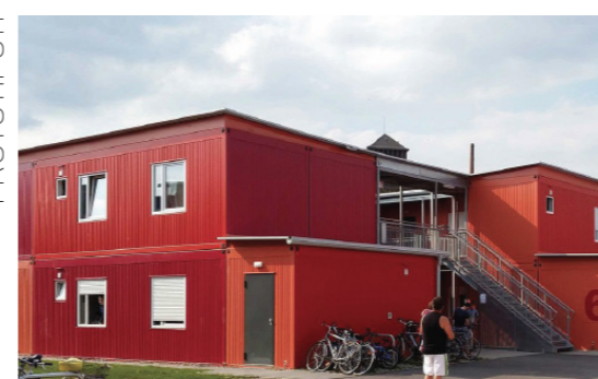
contenedores en Alemania Fagus, Procontain, CHB Bonitz, Ungrund GmbH y Algeco
