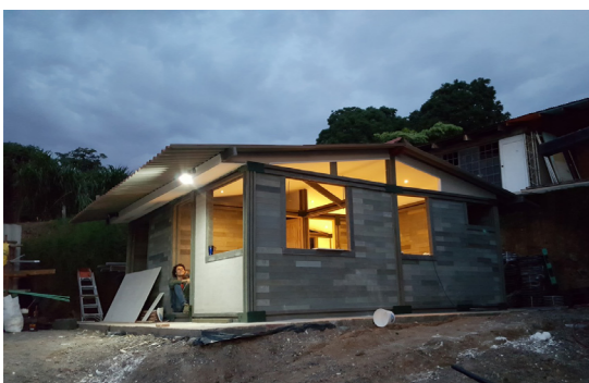
vivienda con ladrillo de plástico reciclado diseñada por el arquitecto Óscar Méndez
