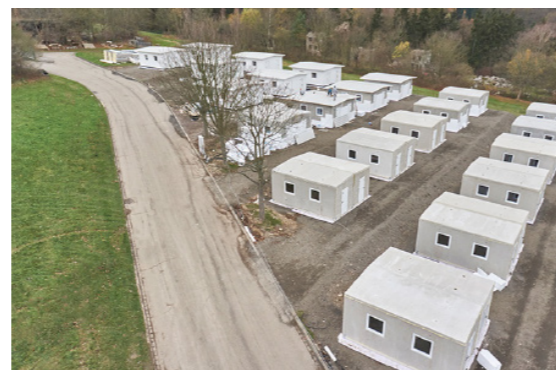
vivienda paneles prefabricados hormigón Peter Görger y Hachmeister
