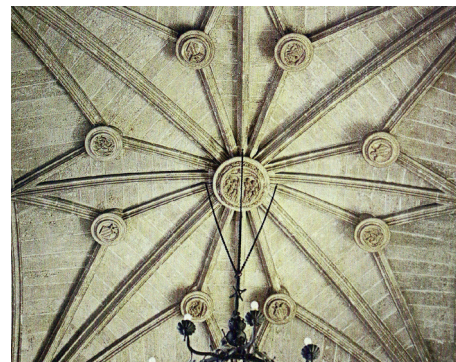
Fig.48. Bóveda estrellada de la capilla de la lonja de Valencia (Navarro Fajardo)
