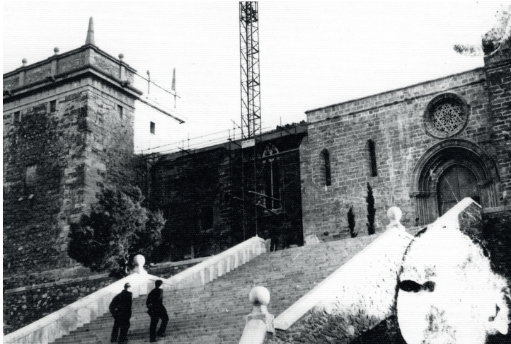
Fig.60. Vista de la escalinata de acceso a la iglesia (Puig AMP)
