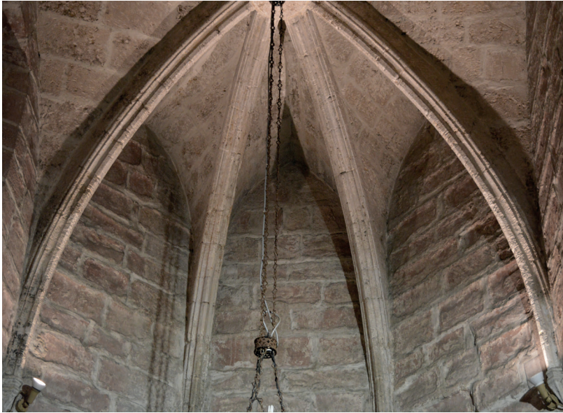
Fig.138. Arcos formeros traseros (Imagen propia)
