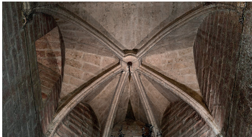
Fig.146. Vista de la plementería del modelo 3D de Photoscan (Dibujo propio)
