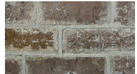
Fig.166. Imagen del sillar rojizo (Imagen propia)
