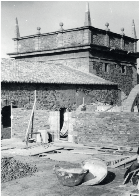
Fig.63. Vista del torreón NO durante la restauración del coro (Puig AMP)
