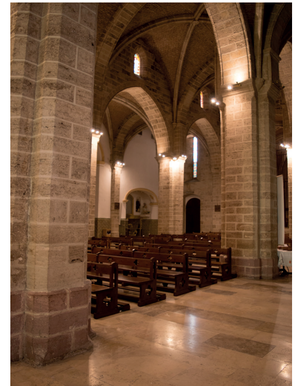
Fig.81. Vista de la nave lateral de la iglesia (Imagen propia)
