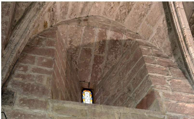
Fig.139. Arcos formeros laterales (Imagen propia)
