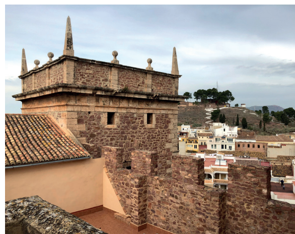
Fig.77. Vista del torreón NO desde la cubierta (Imagen propia)
