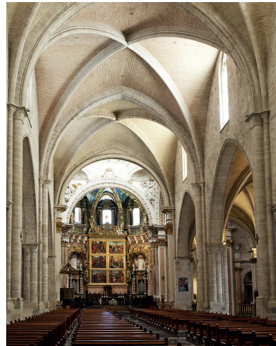
Fig.42. Bóvedas de crucería simple de la catedral de Valencia.
