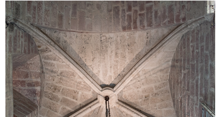
Fig.133. Nervios delanteros (Imagen propia)
