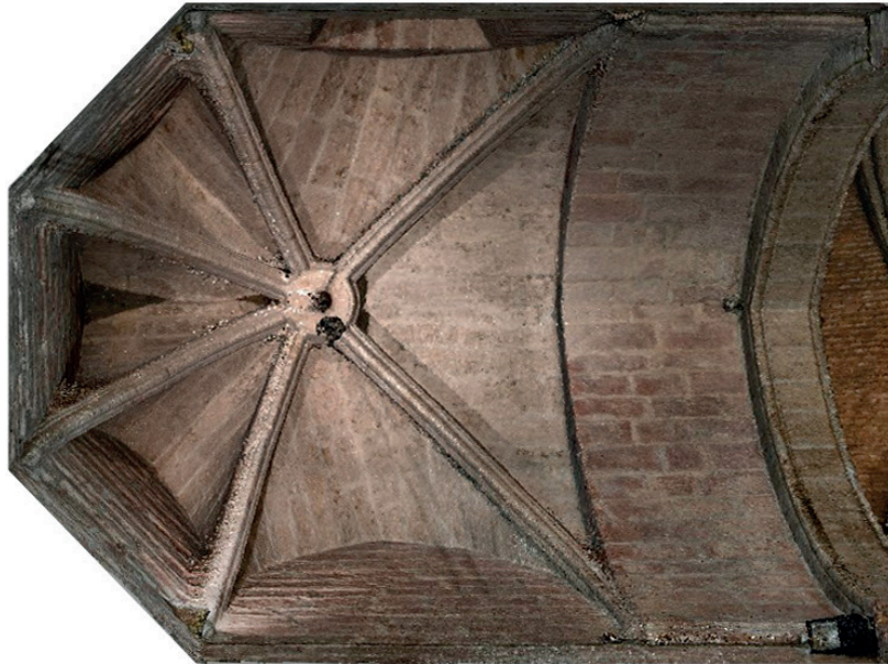
Fig.145. Vista de la plementería del modelo 3D de Photoscan (Dibujo propio)
