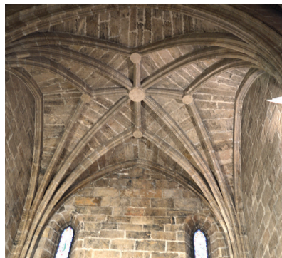
Fig.47. Bóveda estrellada de la capilla de la inmaculada (Imagen propia)
