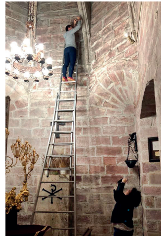
Fig.93. Adrián Pastor tomando el perfil de uno de los nervios de la bóveda.
