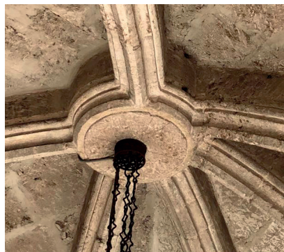
Fig.142. Clave de la bóveda (Imagen propia)
