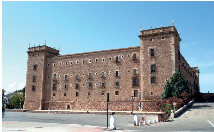
Fig.74. Vista del Monasterio de Santa María de El Puig, fachada Sur (Imagen propia)
