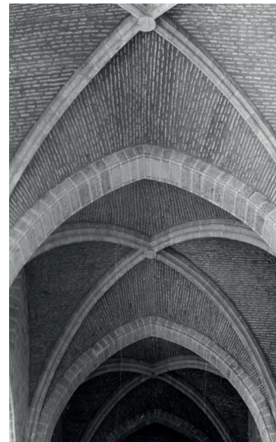
Fig.65. Bóvedas de crucería de la nave central de la iglesia tras la restauración. Año 1968 (Puig AMP)
