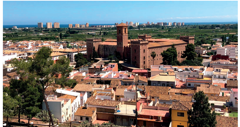
Fig.75. Vista del Monasterio de Santa María de El Puig, fachada Norte (Imagen propia)
