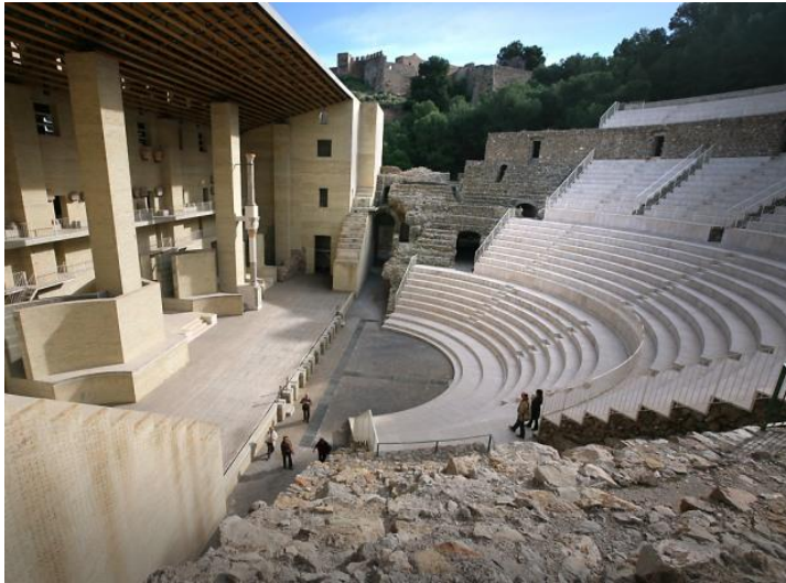
Figura 22: Estado actual del teatro romano de Sagunto
