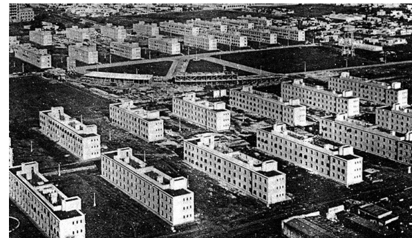
Figura 3.2 | Fotografía. Construcción masiva de vivienda social. (La teja.1949)
