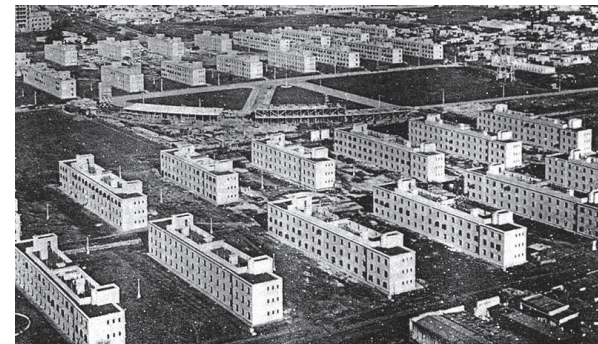
Figura 2.3 | Fotografía. Construcción masiva de vivienda social. (La teja.1949)
