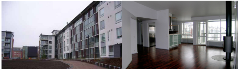
Figura 3.19 | Fotografía. Vista exterior. (Plus Home "Arabianranta") Figura 3.20 | Fotografía. Vista interior. (Plus Home "Arabianranta")
