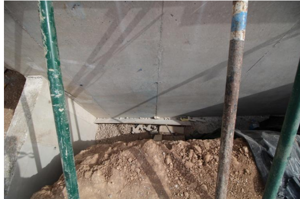
(Figura 82) Foto visita a obra 06_2 Fuente: elaboración propia
