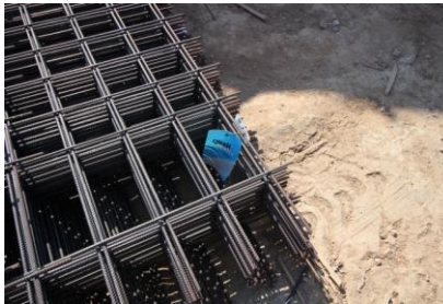
(Figura 77) Foto visita obra 05_1 Fuente: elaboración propia
