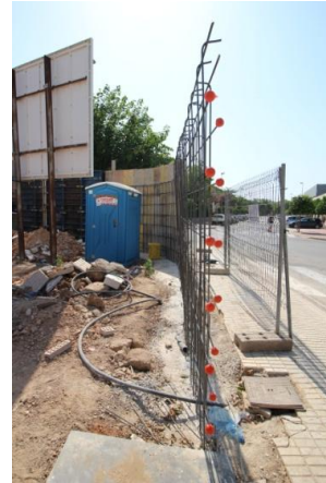
(Figura 90) Foto visita de obra 09_2 Fuente: elaboración propia
