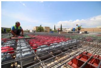
(Figura 86) Foto visita obra 08_1 Fuente: elaboración propia
