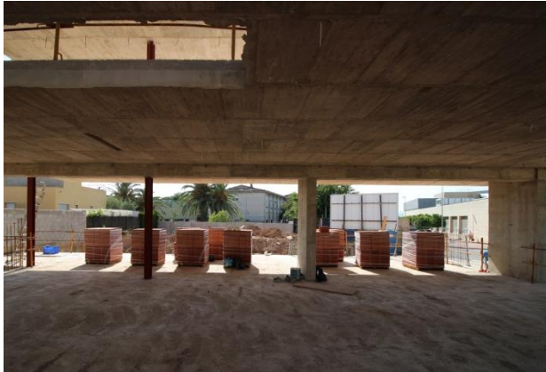
(Figura 89) Foto visita de obra 09_1 Fuente: elaboración propia
