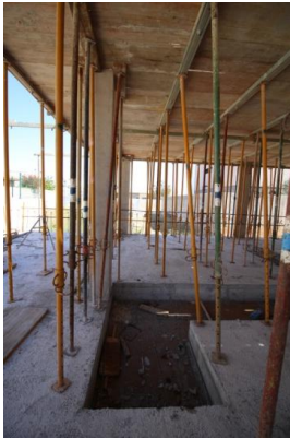
(Figura 81) Foto visita a obra 06_1 Fuente: elaboración propia
