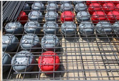
(Figura 78) Foto visita a obra 05_2 Fuente: elaboración propia
