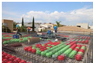
(Figura 87) Foto visita obra 08_2 Fuente: elaboración propia
