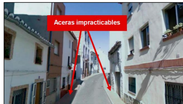
Ilustración 4. Estado actual de la C/ Colón
