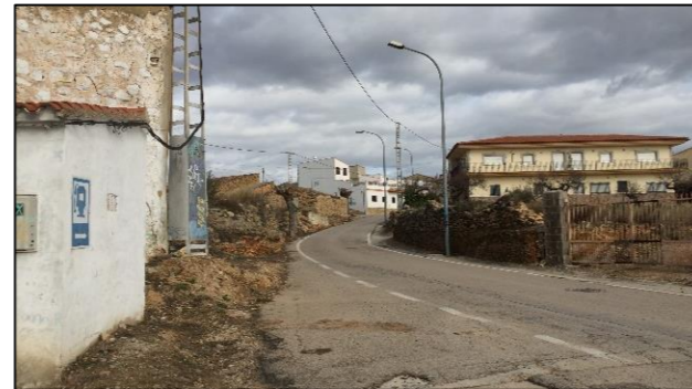
Ilustración 12. Ancho insuficiente en la avenida de la Albufera
