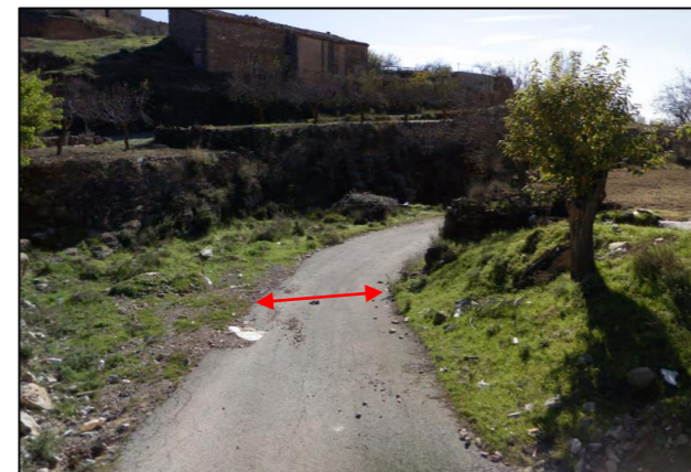
Ilustración 14. Tramo de hormigón, de apenas 2 metros de ancho
