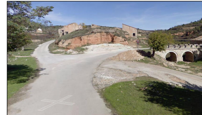
Ilustración 16. Cruce existente en el Camino del Barranco de las Tejerías
