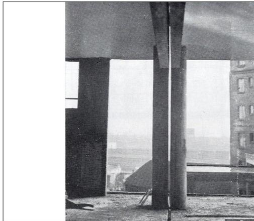
Figura 11. Junta de dilatación.
