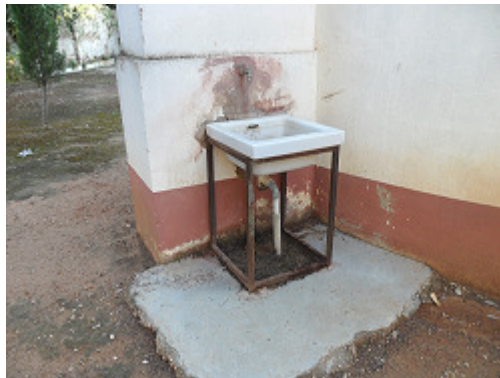
Lavadero adosado al contrafuerte
