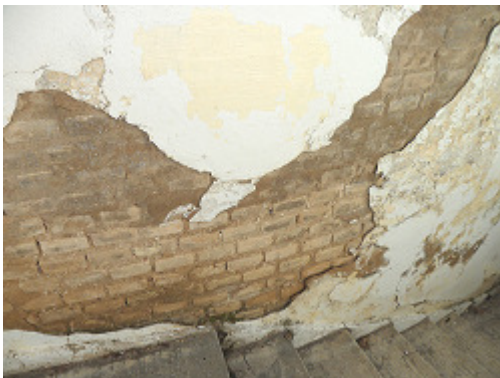
Muro escaleras cripta
