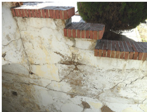
Muro escaleras cripta
