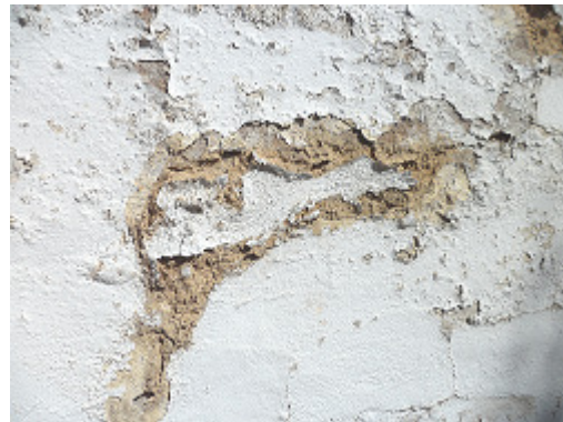
Muro escaleras cripta
