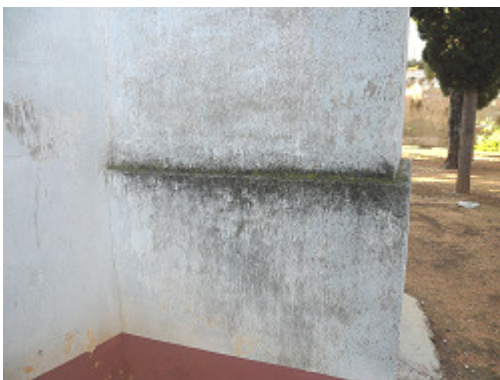
Contrafuerte fachada posterior
