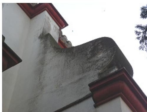
Contrafuerte fachada izquierda
