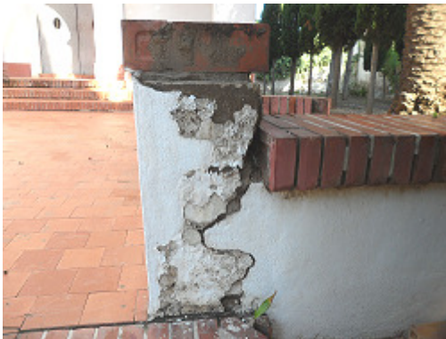
Pretíl escaleras cripta
