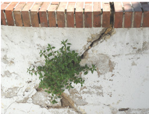
Muro escaleras cripta
