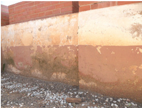
Parte inferior pórtico frontal
