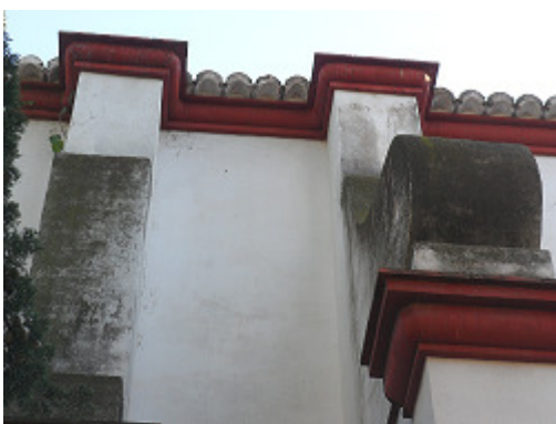
Contrafuertes fachada izquierda
