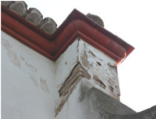
Contrafuerte fachada izquierda
