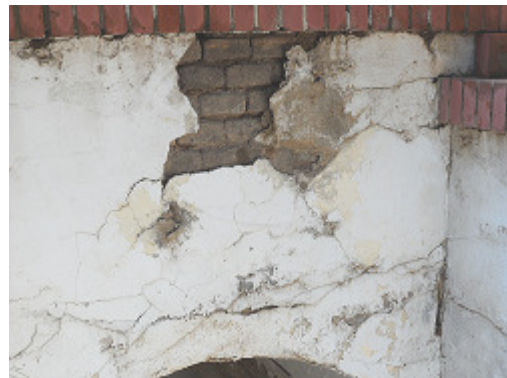
Pretel escaleras cripta
