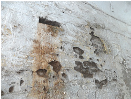
Muro escaleras cripta
