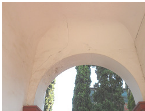
Interior arco del pórtico frontal
