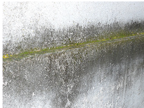
Contrafuerte fachada derecha
