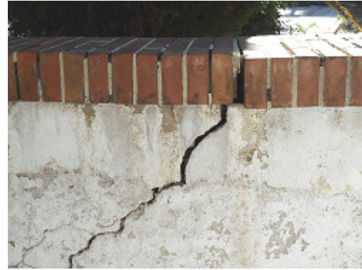
Muro escaleras cripta
