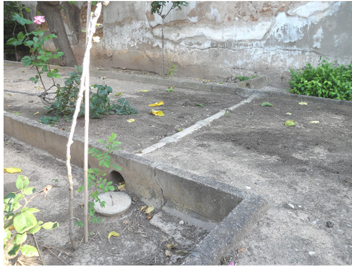
Canalización de riego
