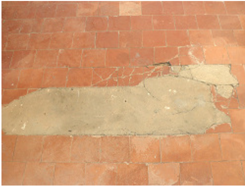
Pavimento pórtico frontal
