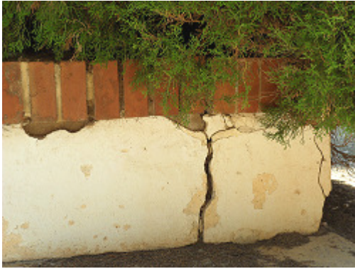
Pretíl escaleras cripta
