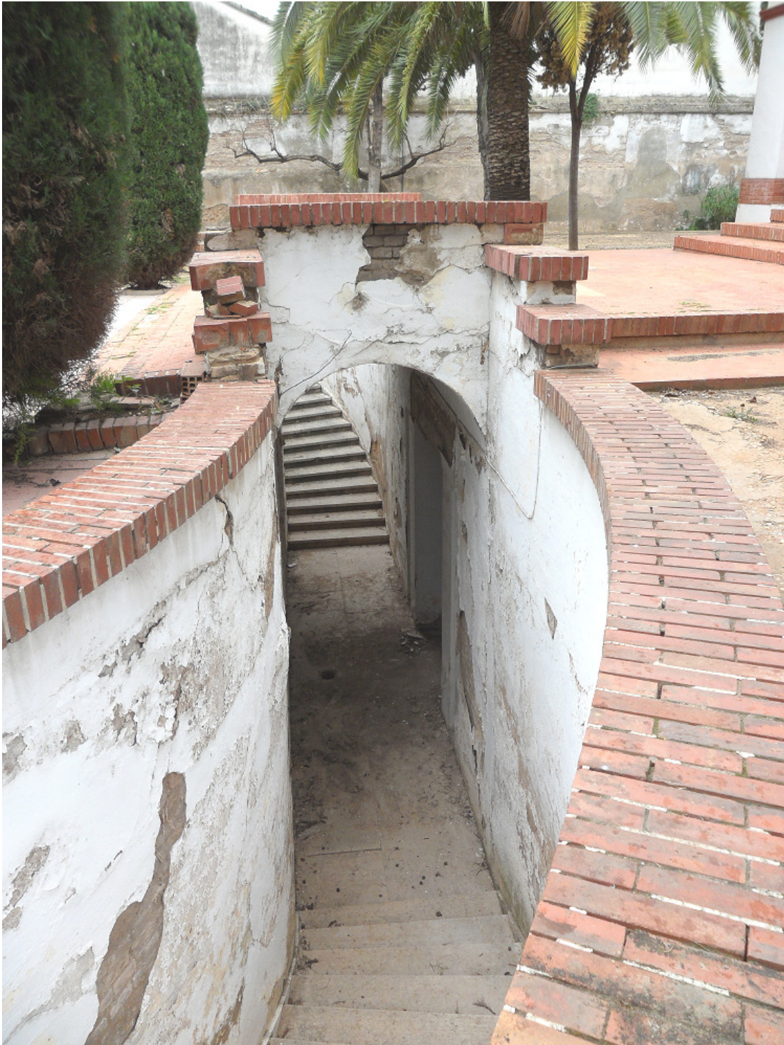
Escaleras de acceso a la cripta
