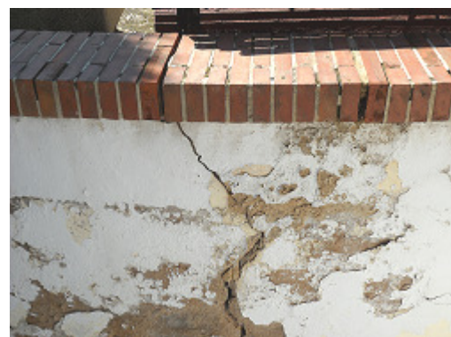
Muro escaleras cripta
