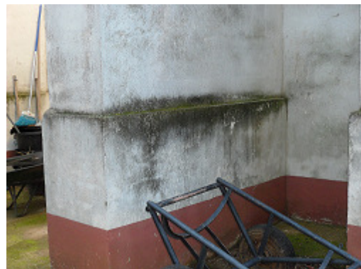
Contrafuerte fachada derecha
