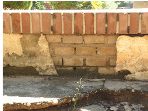
Pretel escaleras cripta
