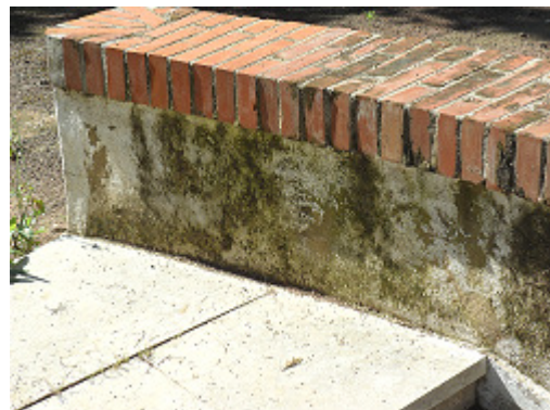
Pretil escalera cripta
