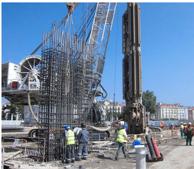
Figura 46: Hidrofresa excavando y ferralla siendo insertada.
