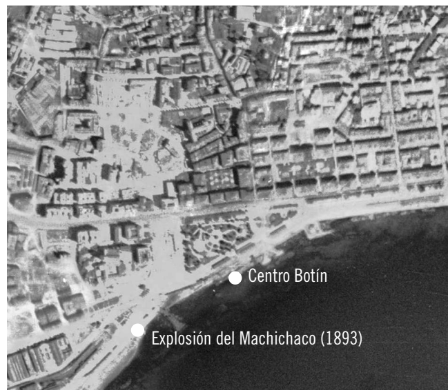
Figura 7: Daños del incendio tras cinco años (1946).
