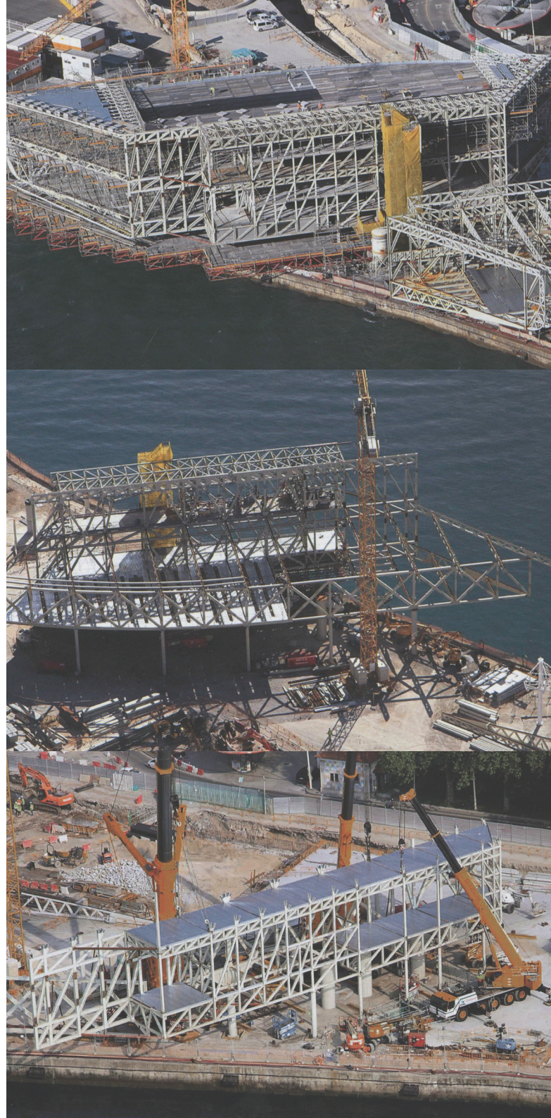
Figura 56: Imágenes aéreas del volumen oeste en construcción.
