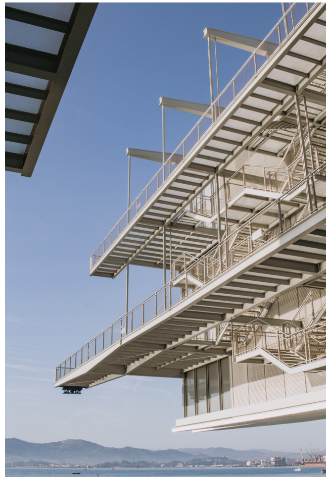
Figura 38: Vigas principales resolviendo el voladizo sur.
