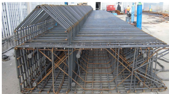
Figura 39: Ferralla de uno de los segmentos del muro pantalla.
