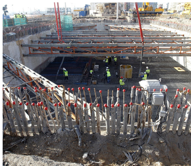
Figura 47: Ejecución de la losa y apuntalamiento de muros.
