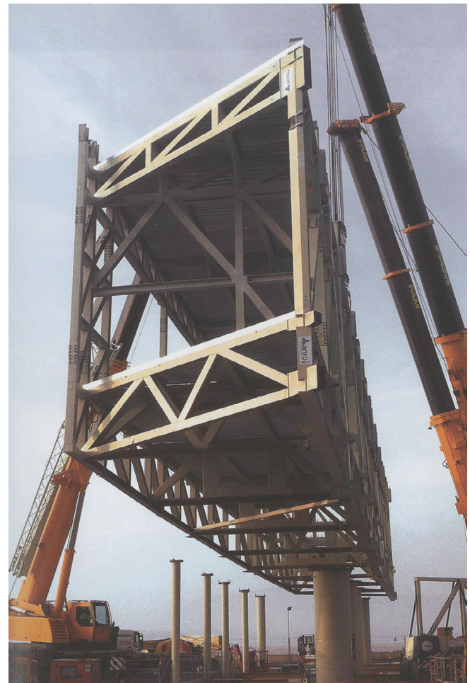
Figura 49: El núcleo principal del volumen oeste siendo izado.
