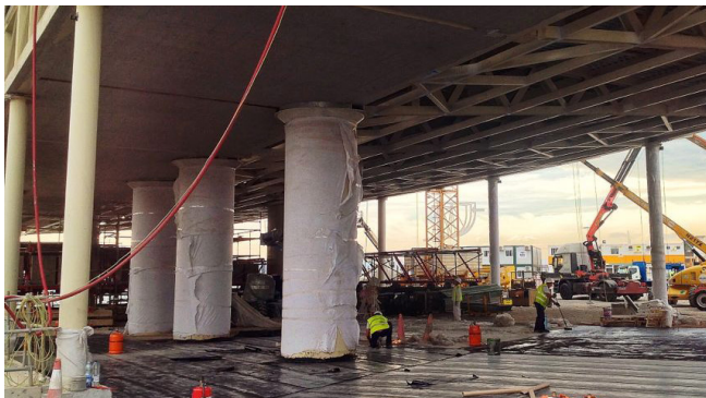
Figura 41: Apoyos de sección circular bajo el volumen oeste.
