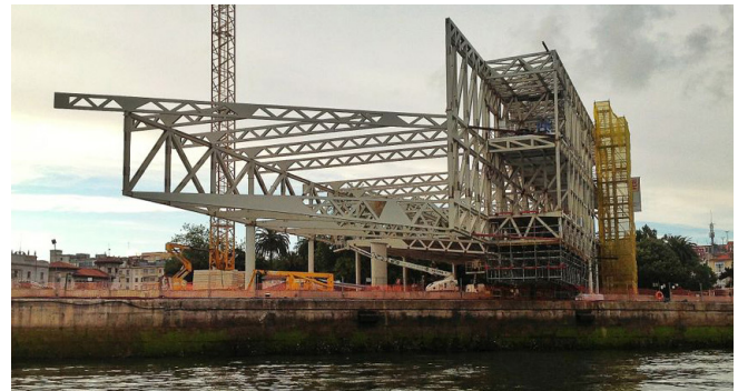
Figura 38: Vigas principales resolviendo el voladizo sur.
