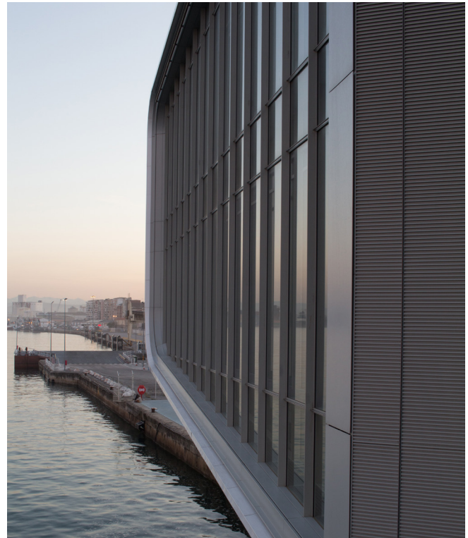
Figura 54: Muro cortina en el frente sur del edificio oeste.
