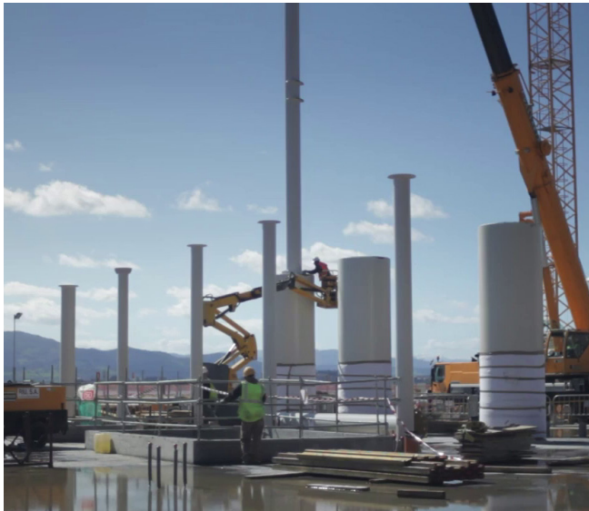
Figura 63: Instantánea del video, con el pilar siendo insertado.
