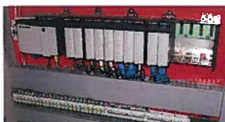
Fig 3.6. Cuadro de control basado en un autómata programable
