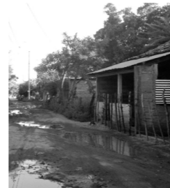
Imagen 41. Infraestructuras urbanas inapropiadas, Niagaragua.
