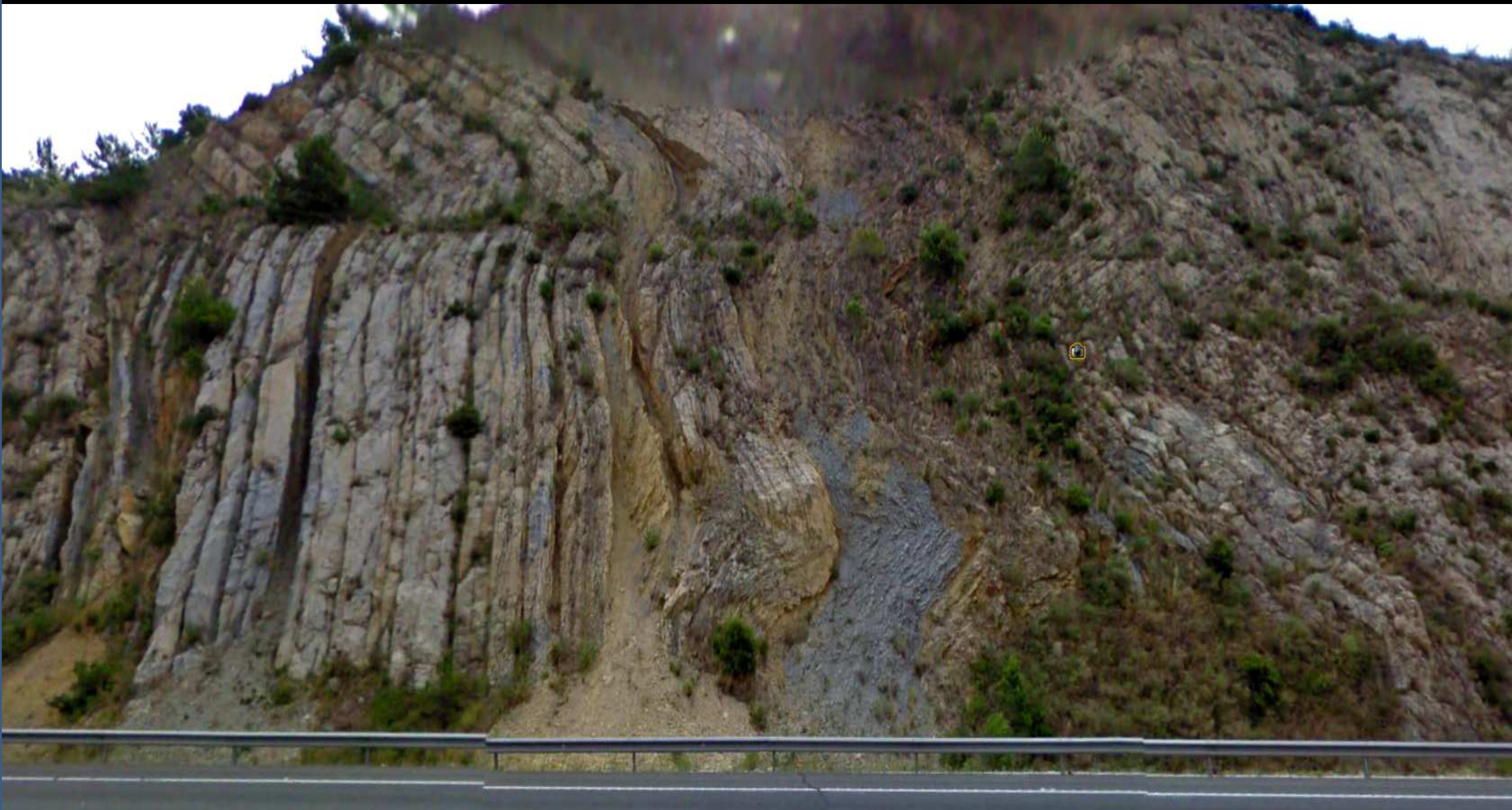
Plegamiento vertical en calizas y margas del Cretácico Inf. Autovía del Mediterráneo. Al S de La Solanera y Fuente La Mata. Centro E. Hoja de Benissa.
