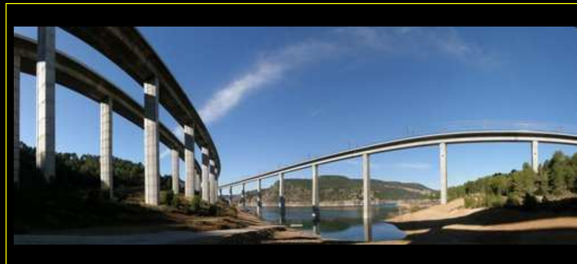
Embalse de Contreras. (foto de El Castor-Google) / desde el Viaducto del Istmo A-3 (El Castor)/ Viaductos AVE y Autovía Madrid- Valencia (SDMV)
