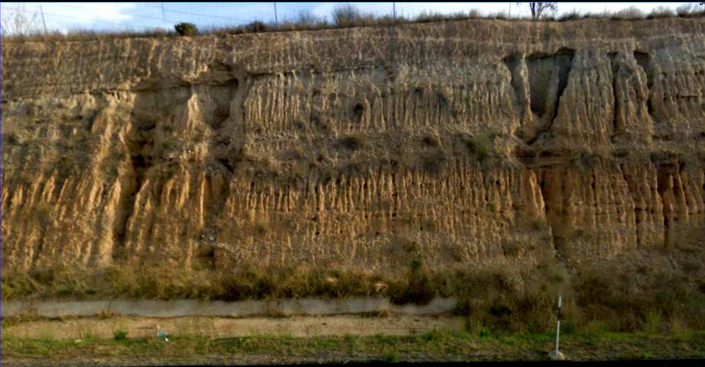
Procesos de erosión en las margas arcillosas rojas, areniscas y conglomerados. Mioceno, Terciario. N Requena, Autovía E. NW Hoja de Requena
