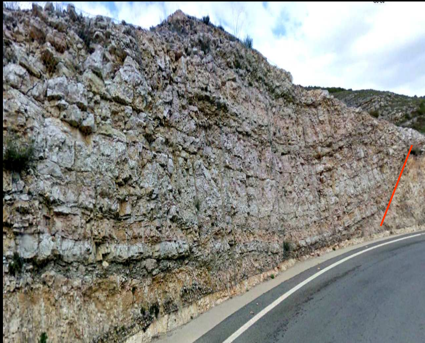
Sinclinal- imagen compuesta- en las calizas y margas amarillentas del Senoniense, Cretácico Sup. Zona de cabalgamiento. S de Onteniente . NE Hoja de O.
