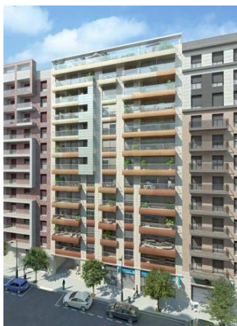
Vista exterior edificio.
