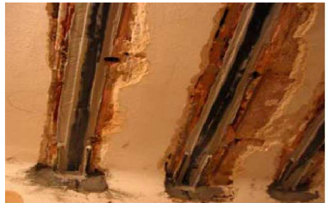
Fig.4.-Refuerzo a flexión mediante adhesivo laminado CFRP, rehabilitación Barcelona (BASF, the Chemical Company)
