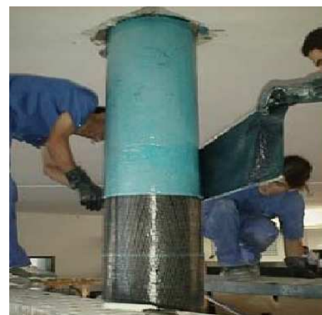
Fig.2.- Refuerzo en pilares, mediante en el puente hoja de fibra de carbono y resina epoxi(BASF)
