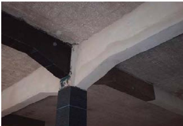
Fig.3.- Refuerzo de jacena a cortante, Mediante hoja de fibra de CFRP y resina epoxi(BASF,the Chemical Company)
