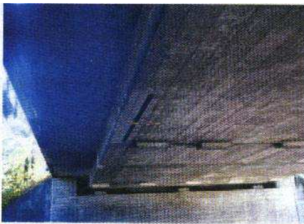
Fig1.- Refuerzo exterior con laminados Ibach en Suiza (S&P, 2000)
