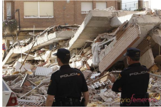
Edificio derruido tras el terremoto en Lorca
