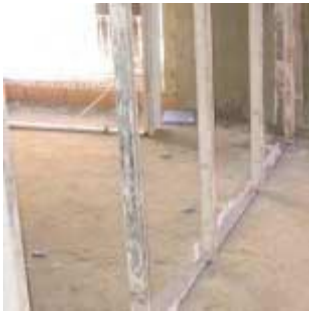
COLOCACIÓN PLOMADAS VERTICALES
