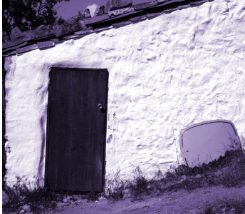
Figura 20. Casa rehabilitada en Bartzell
