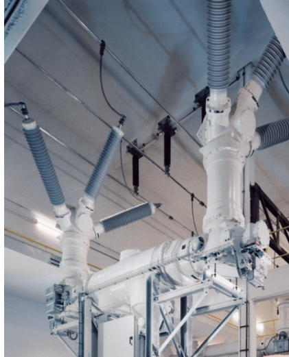
Figura 65. Equipo Compacto Híbrido Aislado en SF6 (HIS) – Siemens.
