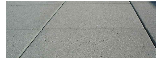
Pavimento de hormigón prefabricado
