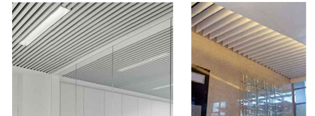
Dos tipologías de falso techo de lamas metálicas
