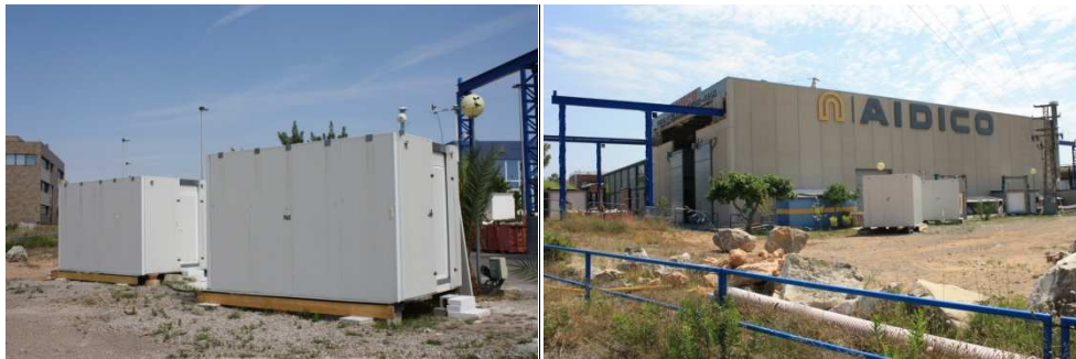
Figura 3.3. Vista cercana de las casetas
