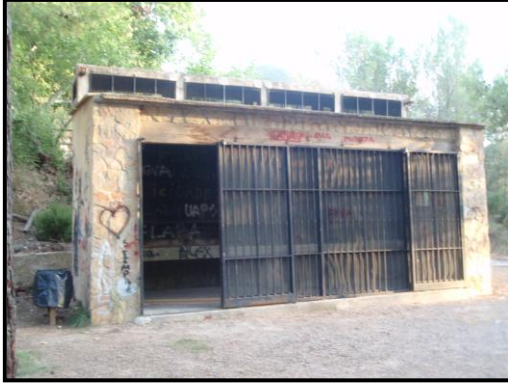
Paellers a la zona del Túnel Font: elaboració pròpia
