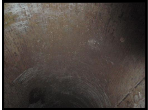
Part superior del túnel, on es pot veure la elaboració que hi van fer a la seua construcció
