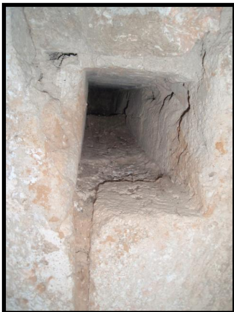
Un dels forats de vigilància de la torre
