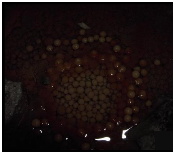
Pedres que s'han format al interior del túnel
