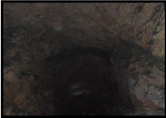
Entrada al túnel
