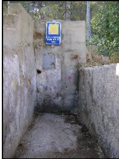
Font d'aigua no potable a la zona del Túnel de Canals Font: elaboració pròpia
