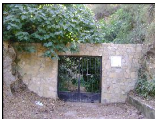
Portalada d'entrada al Túnel de Canals Font: elaboració pròpia
