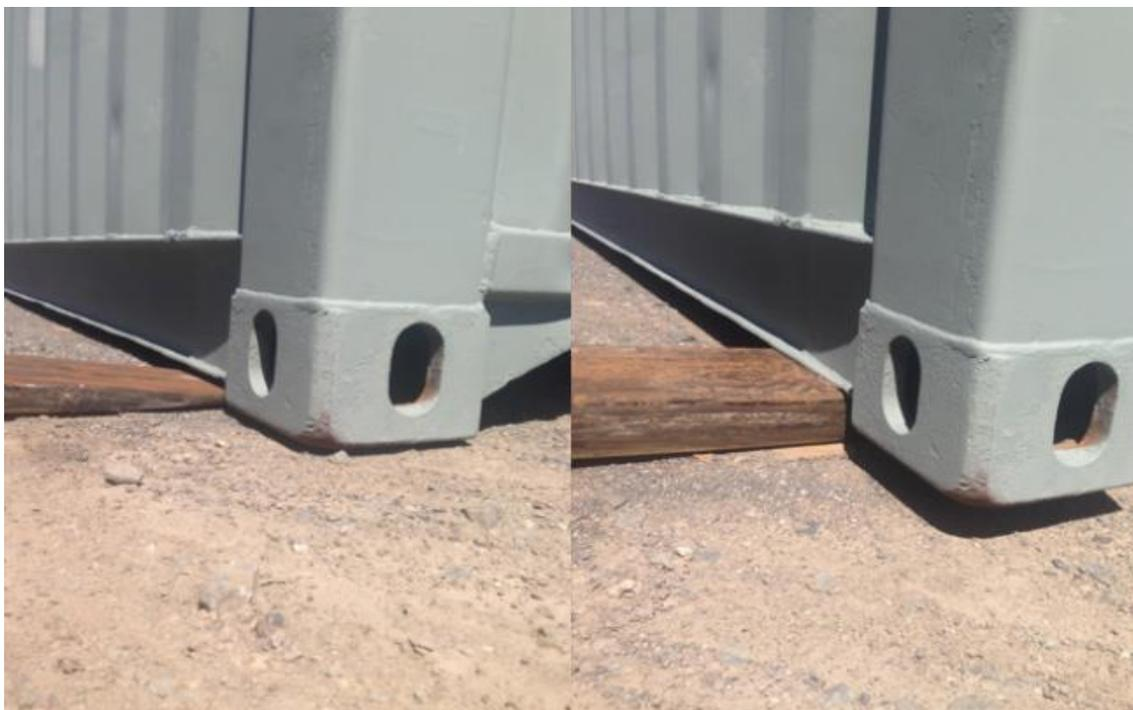
ILUSTRACIÓN 9 DETALLE DE LOS DADO DE UN CONTENDOR. FUENTE: CONTAINEROPTIONS.COM
