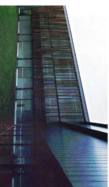
En las orientaciones este y oeste las lamas realizan la función de protector solar; en la norte está para dar unidad visual al edificio y en la orientación sur necesitaremos añadir unos perfiles LD de chapa plegada 60.30.1 que se anclarán a las lamas en diferentes alturas. Como las lamas de madera están en primer plano y tienen mucha más entidad, los perfiles quedan en segundo lugar, por tanto el volumen de aulas se percibe envuelto en una piel de lamas de madera.
