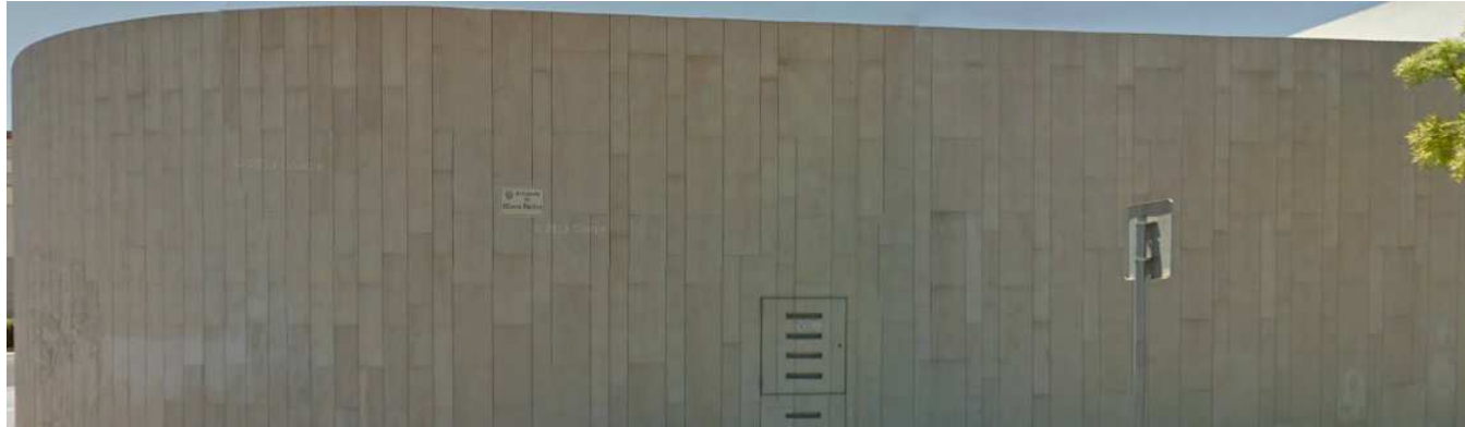
Revestimiento con aplacado de piedra para la sala de conferencias
