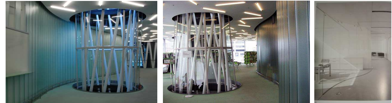
Doble capa de vidrio U-Glass para las zonas de ocio de la planta baja
