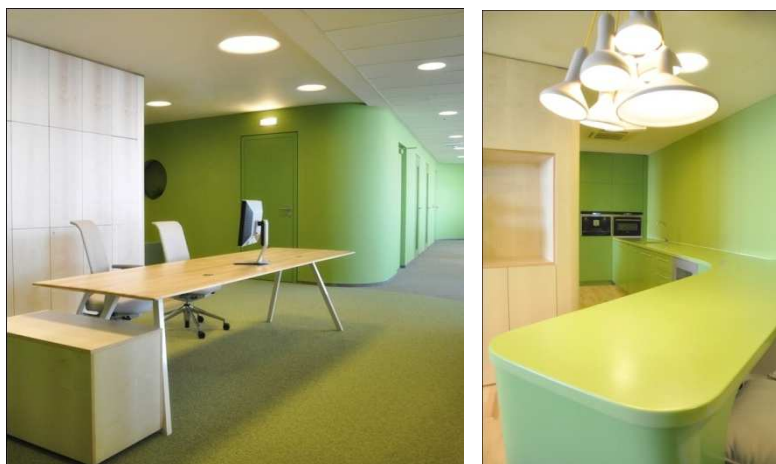
Estructura de cartón yeso doblado
