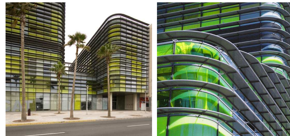
La protección solar de los cerramientos de vidrio de la torre se consigue mediante el uso de lamas horizontales de aluminio.
