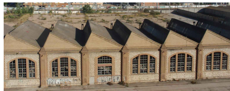
Vista de cubierta desde calle San Vicente Martir
