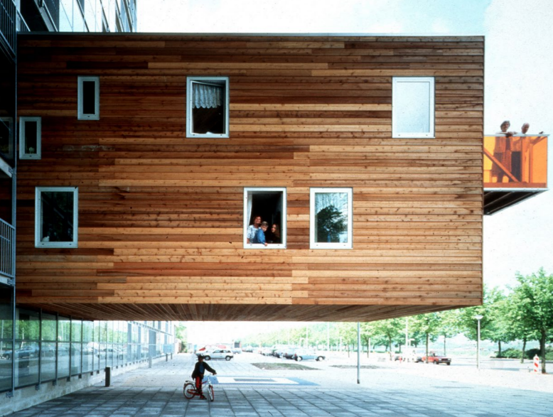
Fig. 2.34 Vivienda colgada de Wozoco.
