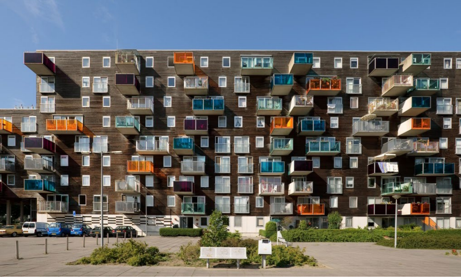
Fig. 1.11 Vista exterior de los apartamentos
