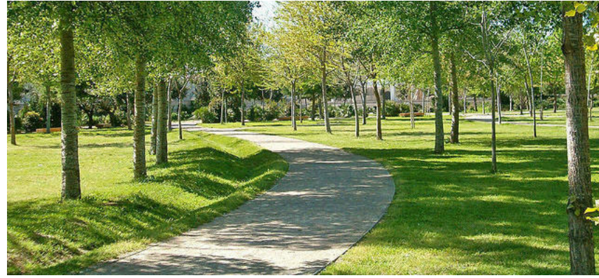
Franjas filtrantes que dirigen la escorrentía hacia el cauce de la Rambleta (Valencia).
