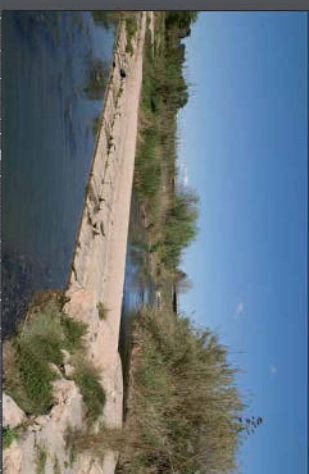
Azud sobre el río Turia para derivación del agua de riego de la huerta. Los azudes constituyen elementos patrimoniales hidráulicos de la Huerta de Valencia.
