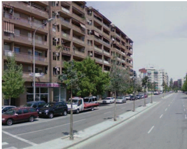
Fuente: elaboración propia Figura 74: “Avenida Tres Forques”
