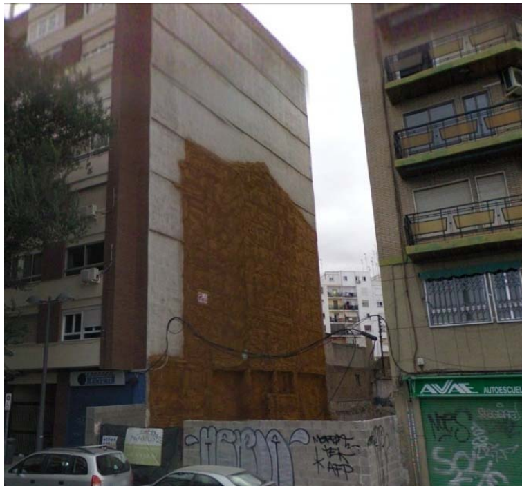
Figura 5.1 6: "Imagen del solar" Fuente: "Elaboración propia"
