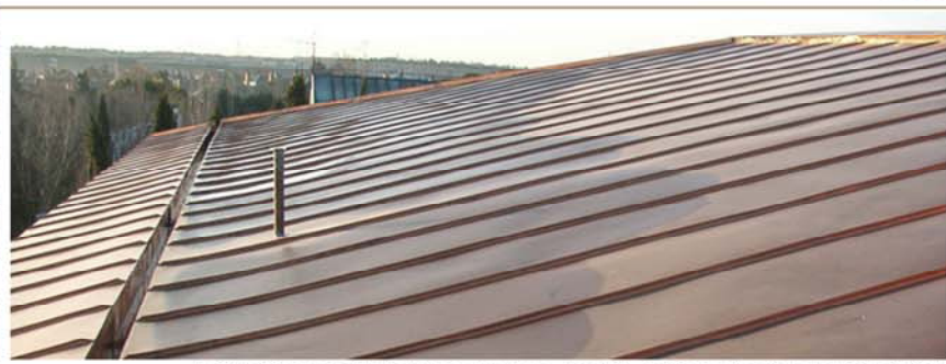
Unifamiliar en Calle de la Ese, Pozuelo, Madrid. Cubierta de oxidado TECU "oxid"
