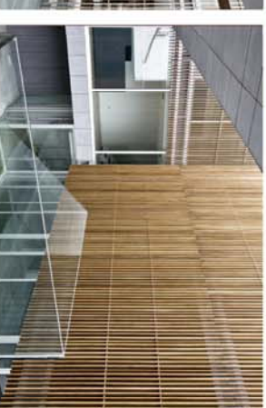
Fachadas este y oeste espacio colaborativo y nave
