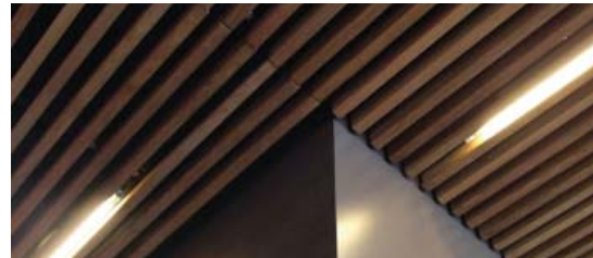
Falso techo Hunter Douglas sistema Grid con listones de madera de haya
