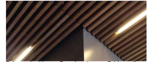
Falso techo Hunter Douglas sistema Grid con listones de madera de haya
