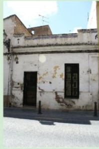
VIVIENDA 10.03a CONSTRUIDA HACE 71 AÑOS
