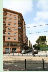
VISTA DESDE CALLE DR VCTE ZARAGOZA
