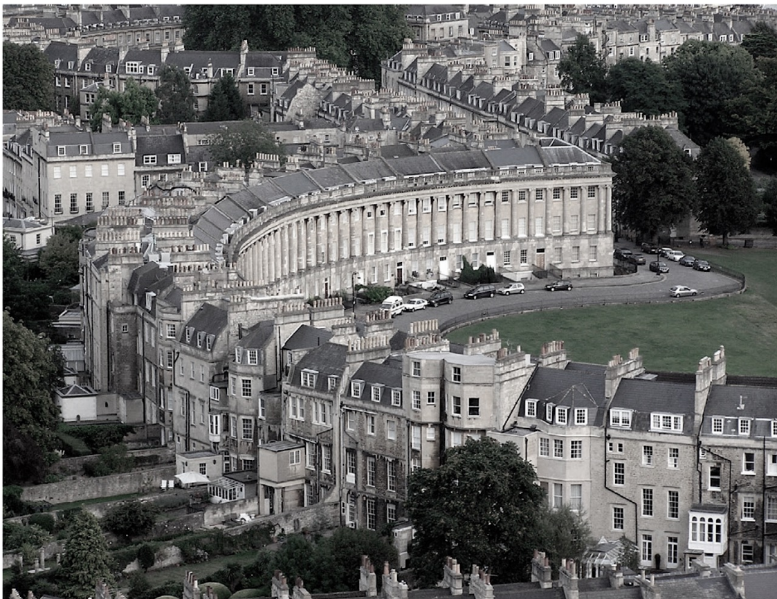
Fig. 38. Fotografía aérea del King's Circus y el Royal Crescent . Adrian Pingstone, 2005. Compartimentación fachada delantera y trasera: el haz y el envés. Fuente: Sánchez García, José María: El caso Bath . Pg 170.
