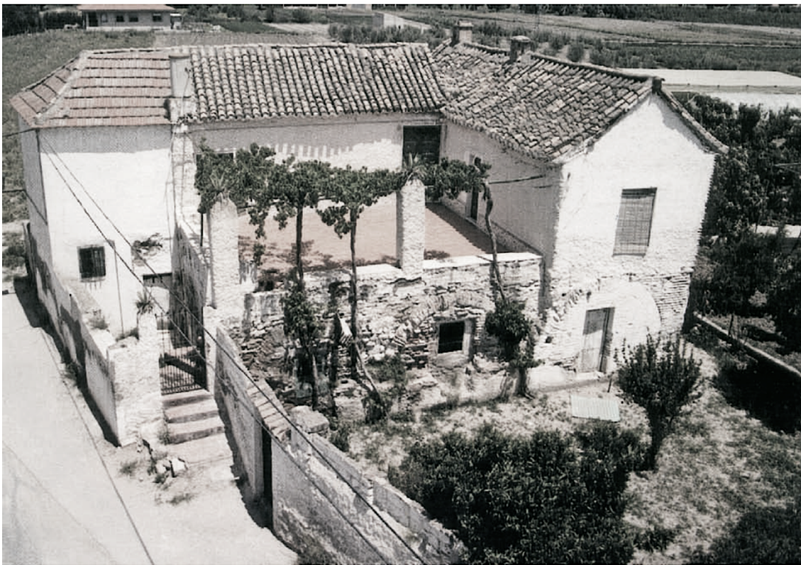
Fig. 17. Vista del edificio del baño de Churriana de la Vega a principios de 1996, última fecha de ocupación de la vivienda. Las bóvedas visibles en la fachada se corresponden, de izquierda a derecha, con las salas fría, templada y caliente del baño. Fuente: López Osorio, José Manuel y Torres Carbonell, José Manuel: El análisis estratigráfico del baño árabe de Churriana de la Vega (Granada): síntesis del conocimiento como base del proyecto de restauración . Pg. 188.
