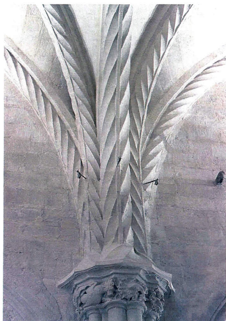
15 y 16. Jarjamentos. Nave mayor. Tramo crucero
