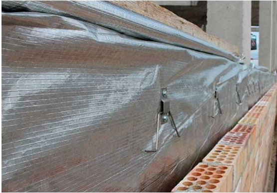
Figura 3: Fachada ventilada Passivhaus Herrera.
