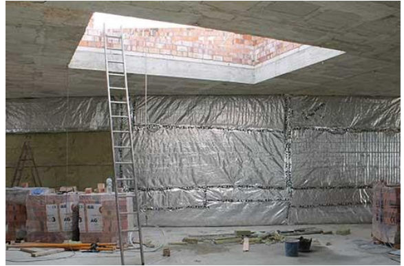
Figura 4: Aislamiento interior en Passivhaus Herrera.
