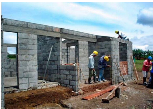
Figura 10: Proceso constructivo de una vivienda de mampostería.
