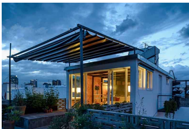
Figura 6: Primera Passivhaus en México.
