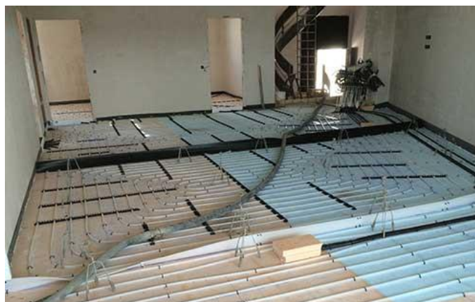
Figura 5: Suelo radiante colocado en Passivhaus Herrera.
