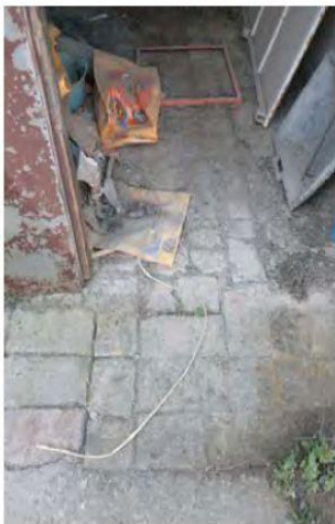
Pavimento de patio.
