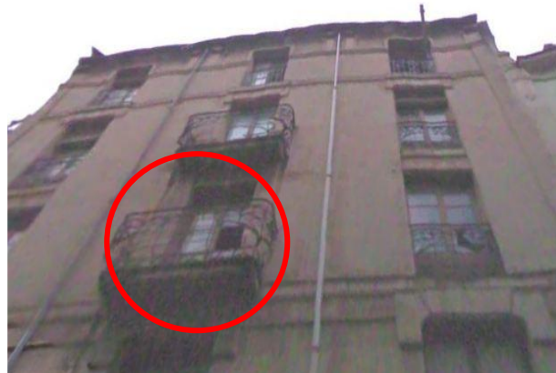
Carpintería exterior del edificio.
