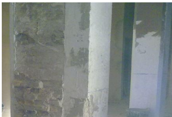
Ejemplo de pilar de la planta baja realizado mediante ladrillo macizo.
