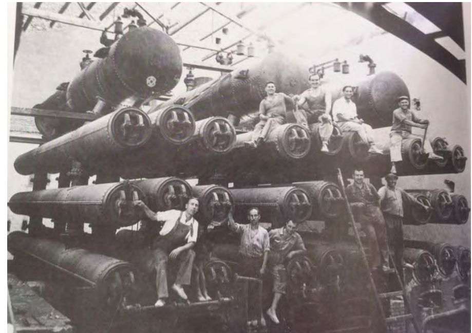
Figura 3.12: Depósitos de agua de la caldera del molino de la Cambra Arrossera (Desc., 1944)
