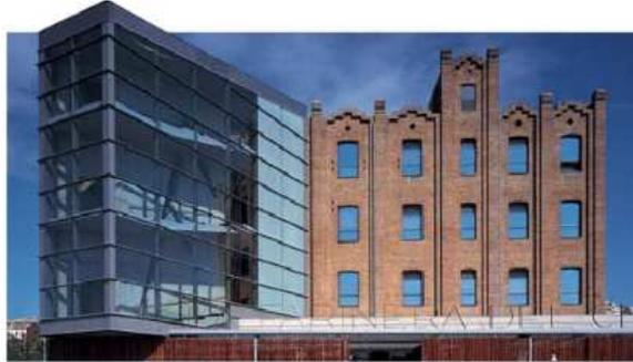
El aspecto trama horizontal se logra a través de tapas clipadas a la estructura del edificio por medio de piezas puntuales de poliamida, las cuales aseguran la ruptura térmica al suprimir el contacto entre la tapa y la estructura.
