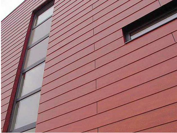
**Muro cortina resuelto con paneles de madera.
