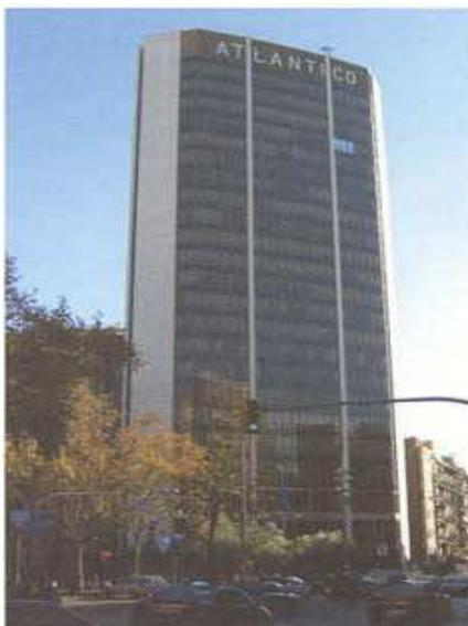
**USO DE VIDRIOS REFLECTANTES Y ABSORBENTES QUE REDUCEN LA RADIACIÓN SOLAR A COSTA DE PERDER LUMINOSIDAD.
