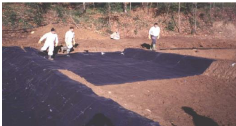
Figura 30. Colocación de geomembranas (García Serrano & Corzo Hernández, 2008).
