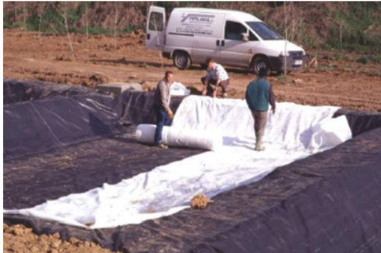
Figura 31. Colocación del geotextil (García Serrano & Corzo Hernández, 2008).
