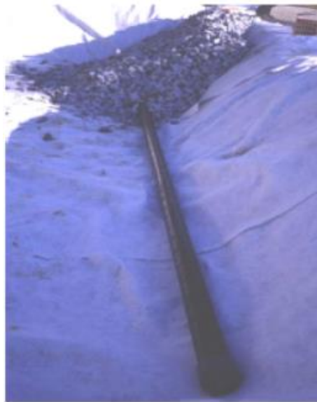
Figura 34. Instalación de la tubería a la salida del humedal (García Serrano & Corzo Hernández, 2008).
