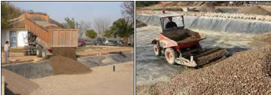
Figura 35. Colocación del material granular en el interior del humedal (Salas Rodríguez, 2017).
