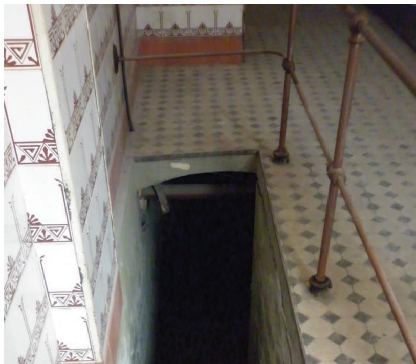
Pavimento preexistente de solado de baldosa hidráulica desgastado por el paso del tiempo. Elaboración propia.
