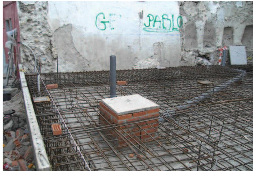
Ejemplo de evacuación de aguas residuales en una losa de cimentación.
