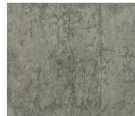
Acabado hormigón pulido en las naves colindantes al molino.
