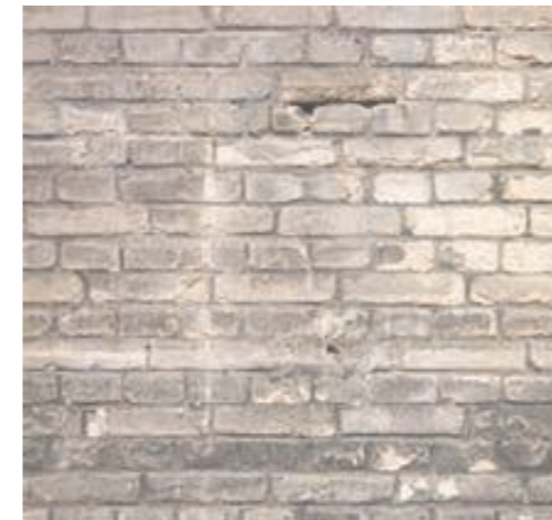
Muros de ladrillo existentes
