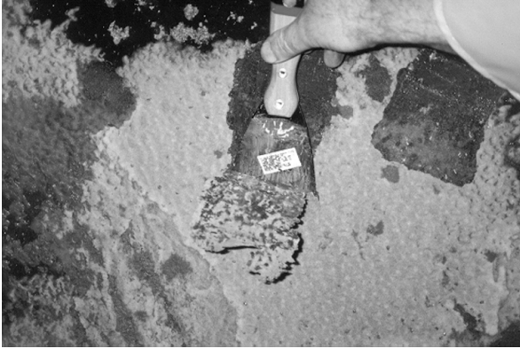
Figura 5: Material que migra y se deposita en las paredes interiores del ACH-G, México.
