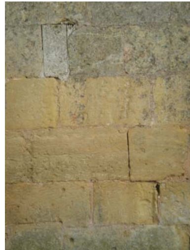
Figura 2.19. Sillería en la fachada Oeste.
