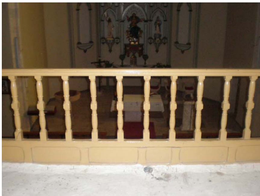
Figura 4.63. Barandilla de madera en el coro.
