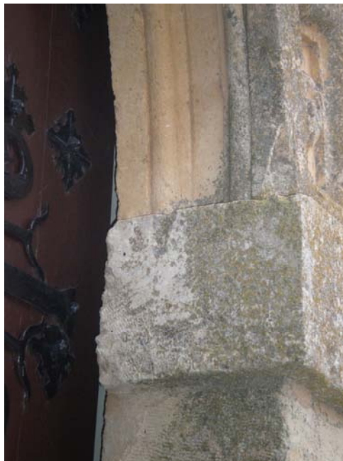
Figura 3.2. Ensuciamiento inorgánico en el arco de la portada principal, combinado con el ensuciamiento biológico.
