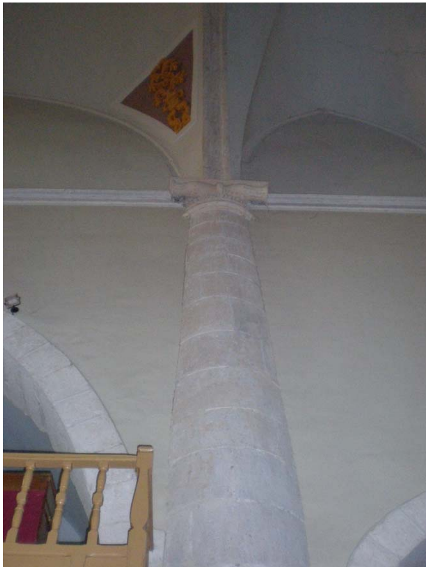
Figura 4.58. Fuste y capitel de las columnas del interior.
