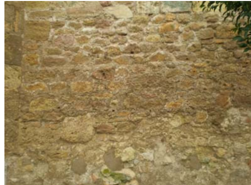
Figura 2.12. Mampostería careada en la fachada Oeste.
