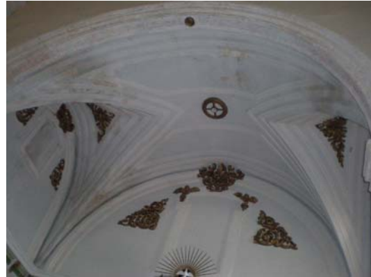
Figura 2.54. Intradós de la bóveda de cañón en el extremo Norte del transepto.
