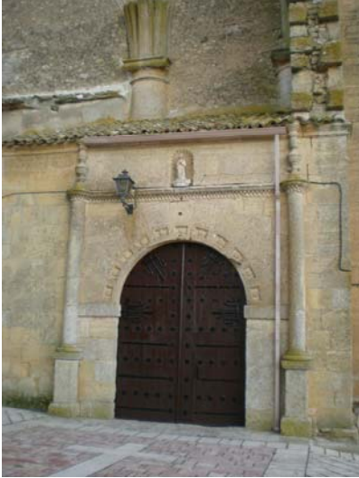
Figura 3.38. Canalón en la fachada Oeste.
