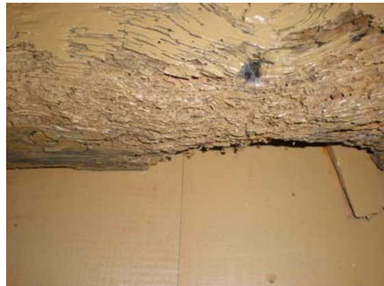
Figura 3.7. Ataque de anóbidos o carcomas en la portada principal.
