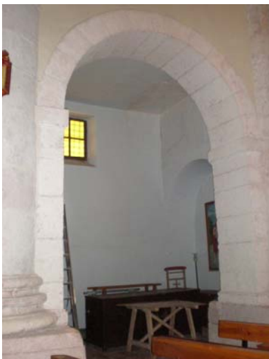
Figura 2.16. Sillería aplantillada en un arco del interior de la iglesia.
