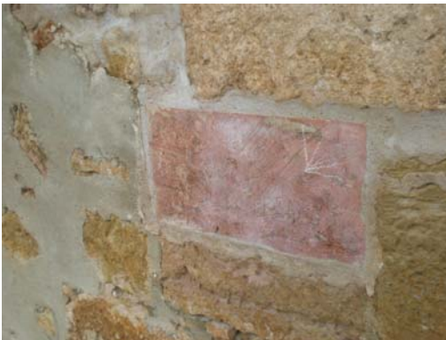
Figura 3.40. Reposiciones en la fachada Sur.
