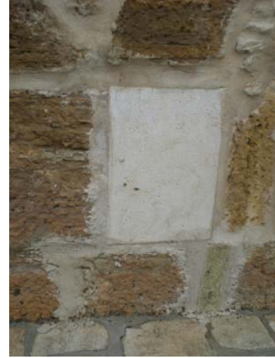
Figura 3.22. Colocación de piedra artificial de distintas características que la original.
