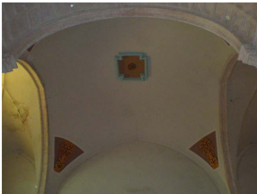
Figura 4.22. Bóveda vaída del crucero.
