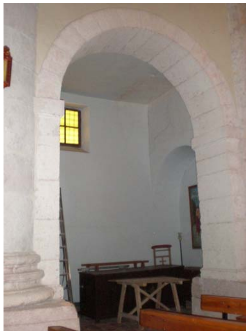
Figura 4.21. Dependencia anexa al lado Norte del transepto.
