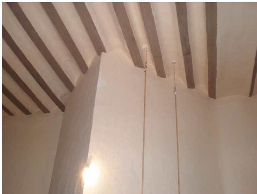
Figura 4.41. Sacristía. Encuentro del forjado con el contrafuerte.
