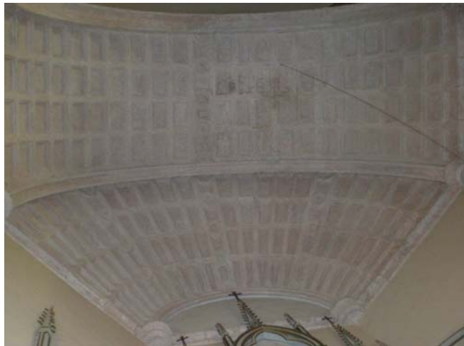
Figura 3.64. Bóveda de cañón y bóveda de cañón abocinada, ambas encasetonadas, del ábside.
