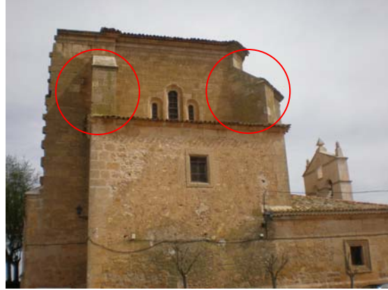
Figura 2.20. Contrafuertes en la fachada Sur.
