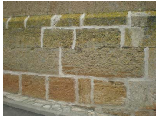
Figura 3.41. Rejuntados en la fachada Este.
