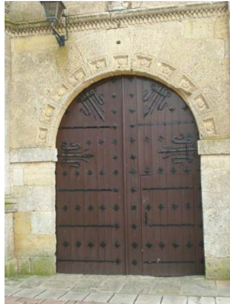
Figura 2.15. Fábrica de sillería en la portada principal.
