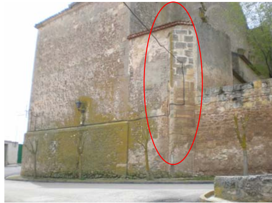
Figura 2.22. Contrafuerte pequeño en la fachada Norte.
