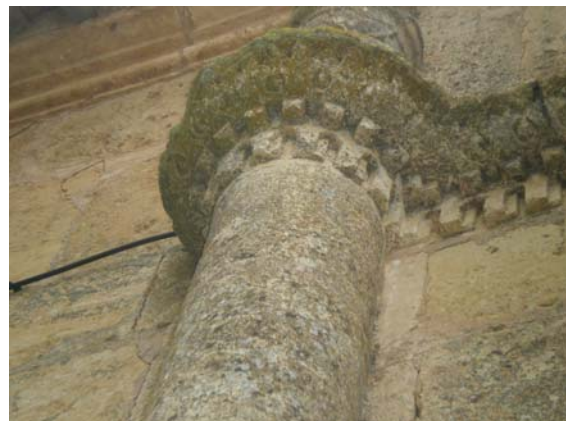
Figura 3.18. Erosión mecánica.
