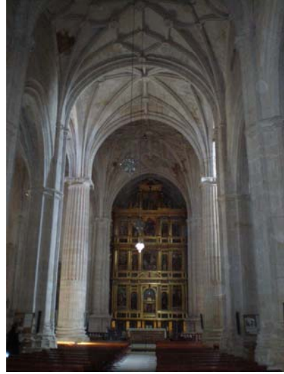
Figura 2.4. Nave central en el interior de la iglesia.
