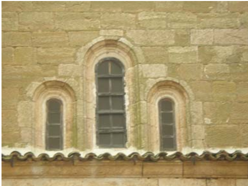
Figura 2.29. Ventanas en la fachada Sur que iluminan el transepto.
