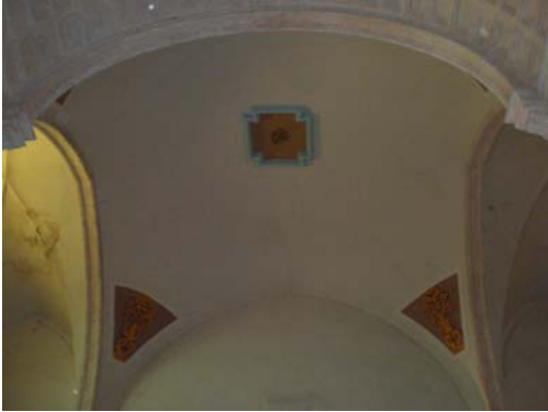
Figura 2.41. Arcos apuntados de la bóveda vaída.
