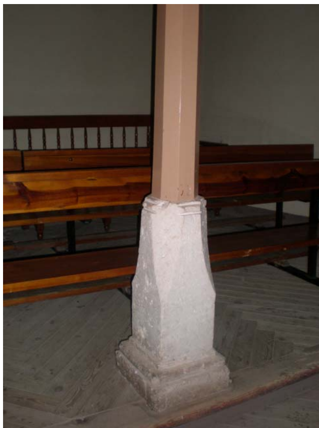
Figura 4.60. Base de piedra de los pilares del coro.
