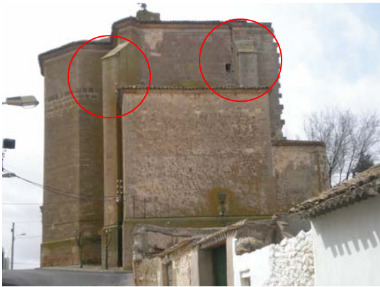
Figura 2.21. Contrafuertes en la fachada Norte.
