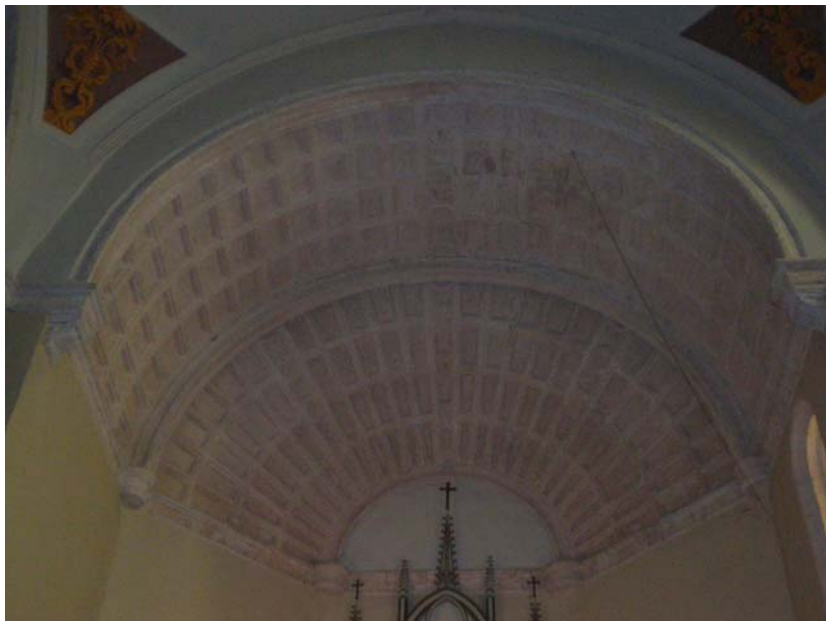
Figura 4.26. Bóveda de cañón recto y bóveda de cañón abocinada, ambas encasetonadas, del ábside.
