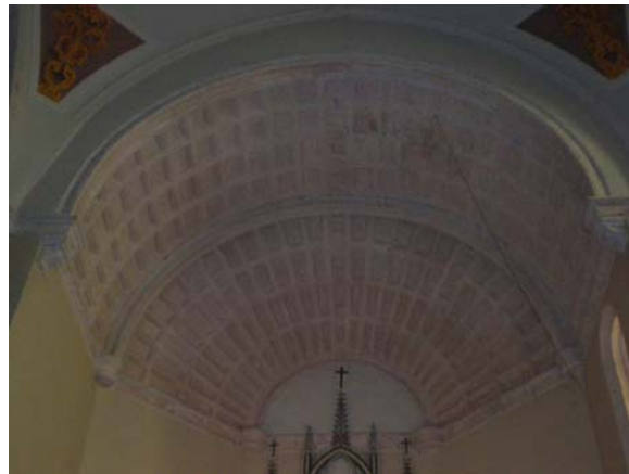
Figura 2.50. Bóveda de cañón y bóveda de cañón abocinada, en el ábside.
