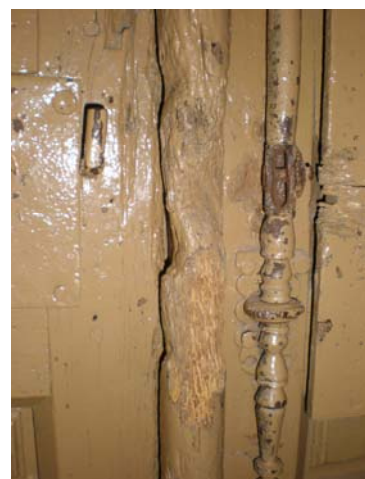
Figura 3.9. Ataque de anóbidos o carcomas en el cortaviento de la entrada.
