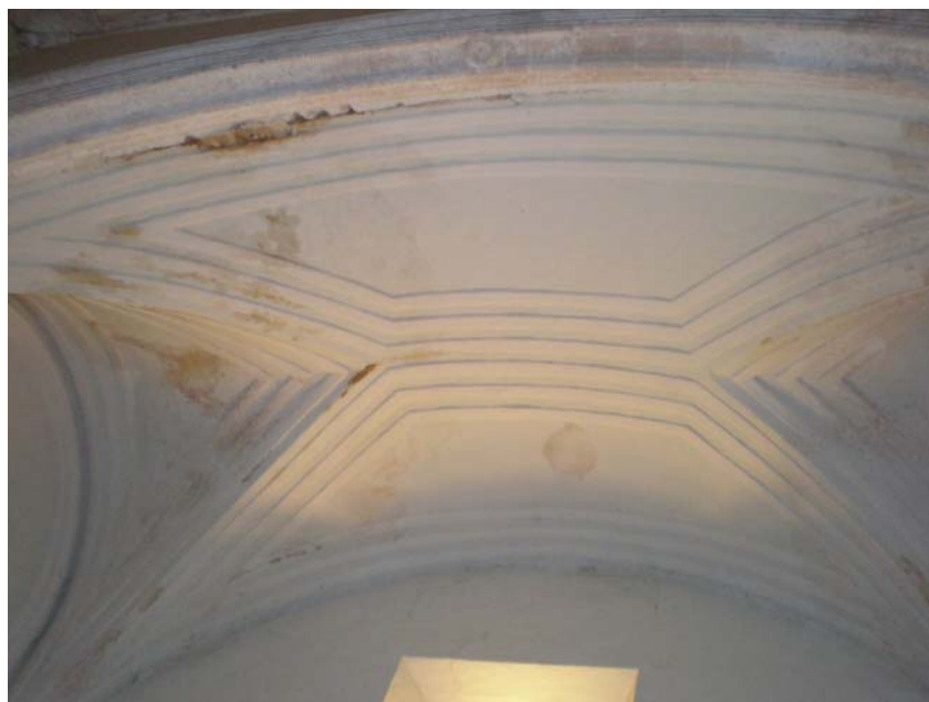
Figura 4.30. Bóveda de cañón con lunetos en el extremo Sur del transepto.
