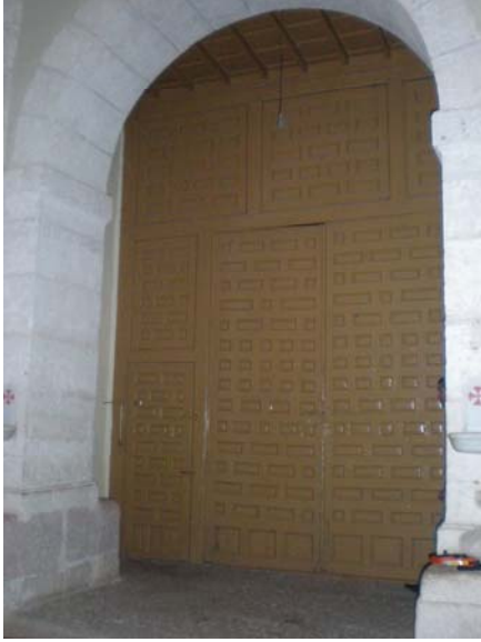
Figura 2.33. Arco de medio punto en la zona de cortaviento.
