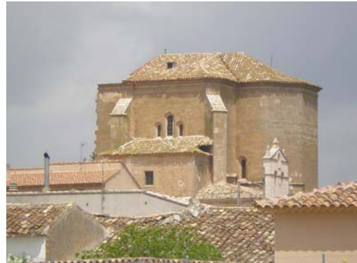
Figura 2.30. Fachada Sur en la que se observa la ventana que ilumina el altar.
