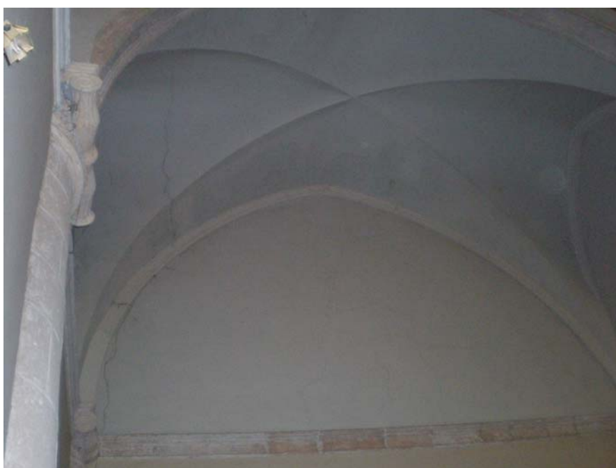
Figura 4.29. Bóveda aristada del lado Norte del crucero.
