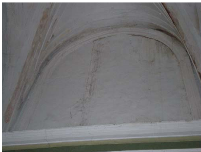
Figura 3.1. Ensuciamiento inorgánico en la capilla del extremo Sur del transepto.
