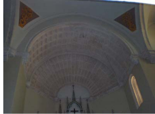
Figura 2.42. Arco de medio punto bajo al arco apuntado de la bóveda vaída.
