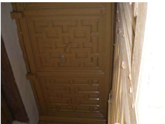
Figura 4.33. Detalle del falso techo de madera.
