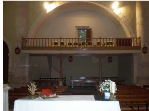
Figura 2.35. Arco de medio punto en el coro.
