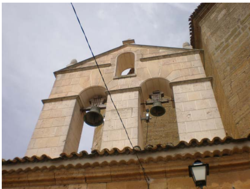
Figura 4.12. Campanario en la fachada Este.
