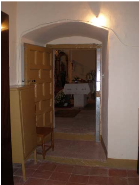
Figura 4.35. Puerta de acceso a la sacristía vista desde el interior de la misma.
