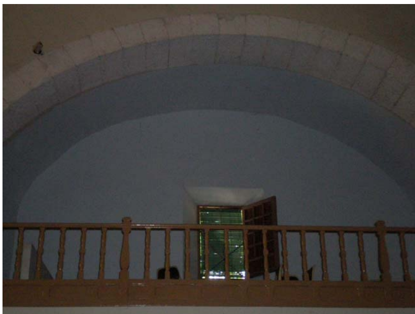
Figura 4.27. Bóveda de cañón sobre el coro.
