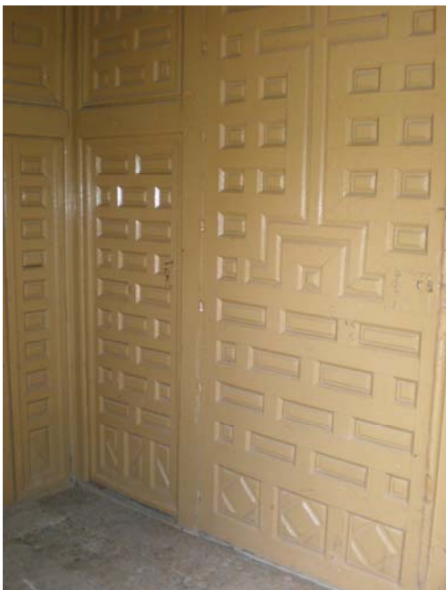
Figura 4.32. Detalle del cortaviento.
