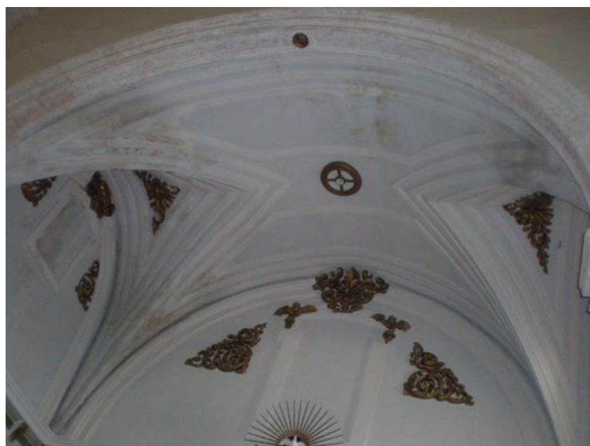
Figura 4.31. Bóveda de cañón con lunetos en el extremo Norte del transepto.
