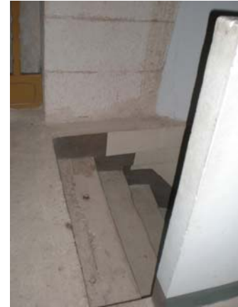
Figura 2.44. Segundo tramo de la escalera de acceso al altílo.
