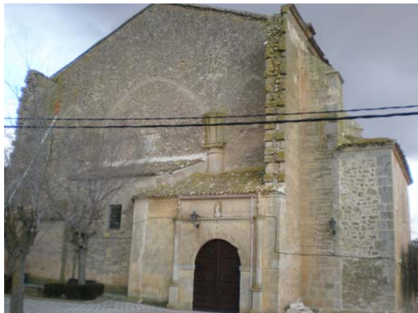
Figura 2.1. Vista general de la fachada principal (Oeste) de la "Iglesia Nuestra Señora de la Asunción".
