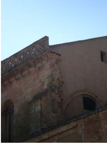
Figura 2.7. Muro inacabado de la Iglesia parroquial de Santiago Apóstol.
