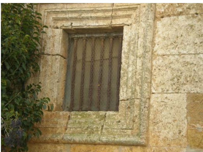
Figura 4.51. Ventana en la fachada Sur recayente a la sacristía.
