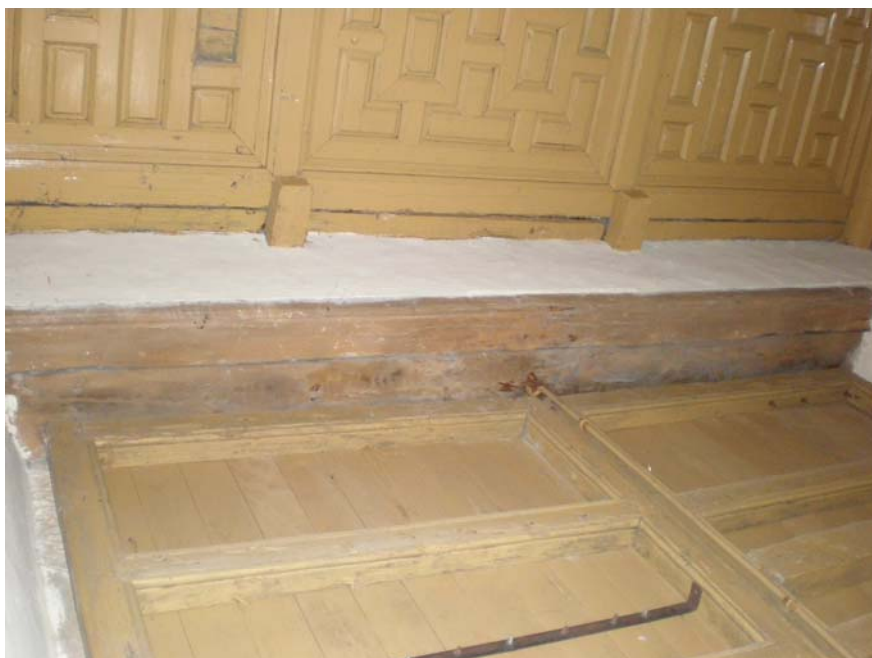
Figura 4.49. Portada principal vista desde el interior.
