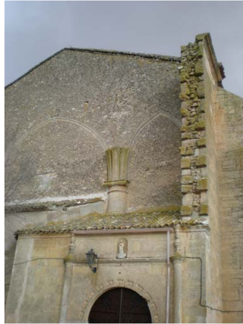
Figura 2.10. Técnica del "Opus Emplecton" en la fachada Oeste.
