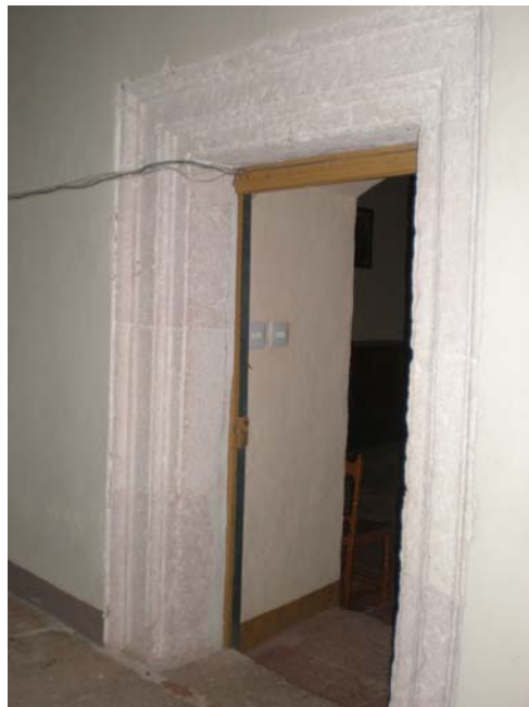
Figura 4.36. Puerta de acceso a la sacristía vista desde el altar.
