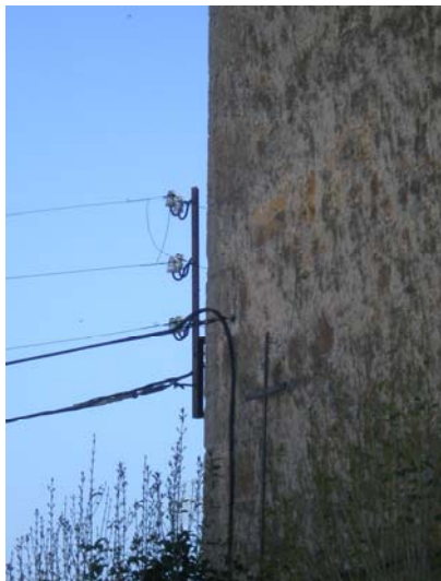
Figura 3.42. Instalación de un servicio público en la fachada Norte.
