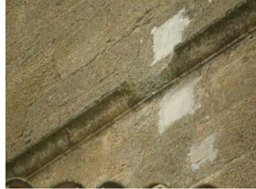
Figura 3.39. Reposiciones en la fachada Este.
