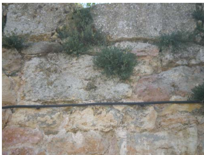
Figura 3.5. Vegetales superiores en la fachada Norte.
