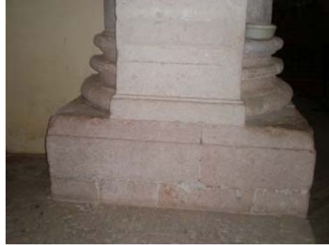
Figura 2.25. Perfil de la base de una de las columnas.
