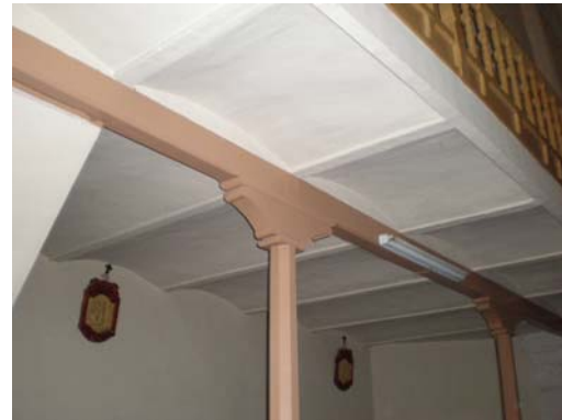
Figura 2.45. Forjado del coro.
