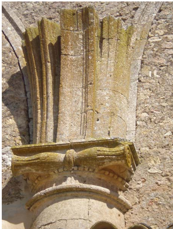
Figura 4.44. Capitel de las columnas de la fachada Oeste, visto desde el exterior.
