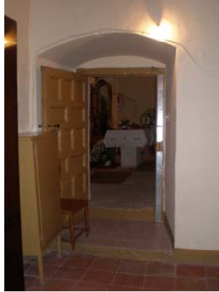
Figura 2.38. Puerta de acceso a la sacristía, vista desde el interior de la misma, con un arco rebajado.
