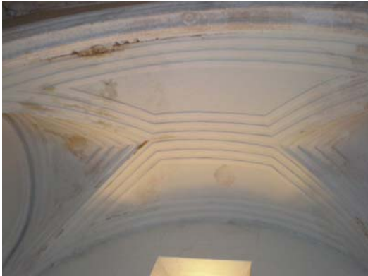
Figura 2.53. Intradós de la bóveda de cañón en el extremo Sur del transepto.
