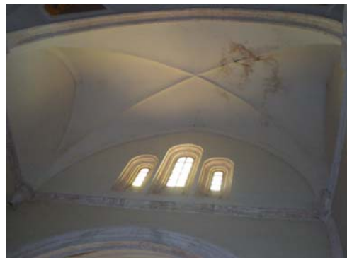
Figura 2.40. Arcos apuntados en la bóveda aristada del lado Sur del crucero.
