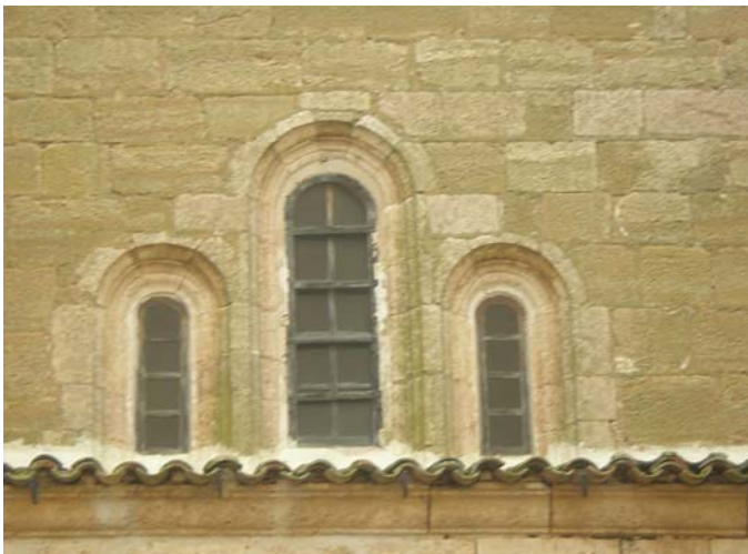
Figura 4.50. Ventanas en la fachada Sur del transepto.
