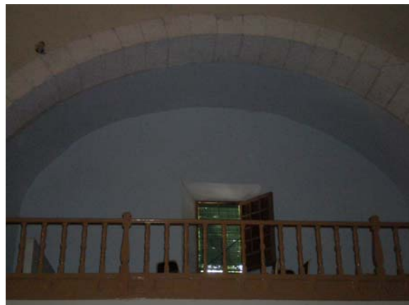
Figura 2.51. Bóveda de cañón en el altílo.
