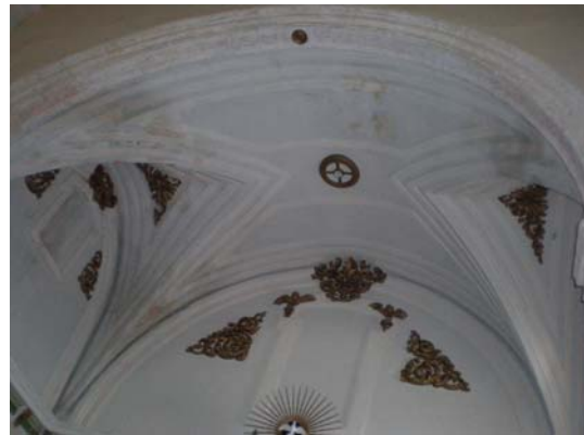
Figura 3.59. Intradós de la bóveda de cañón con lunetos de la capilla del extremo Norte del transepto.
