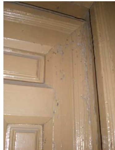
Figura 3.10. Ataque de anóbidos o carcomas en una de las puertas de la entrada.
