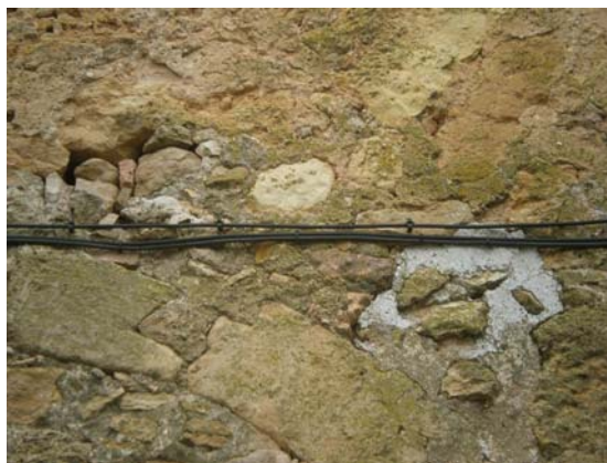
Figura 3.19. Erosión física.
