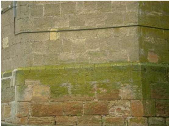
Figura 2.18. Sillería en la fachada Este.
