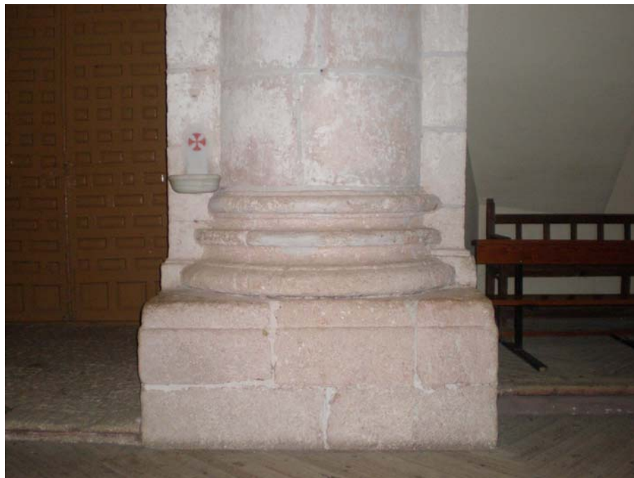
Figura 4.56. Base de las columnas del interior (alzado).
