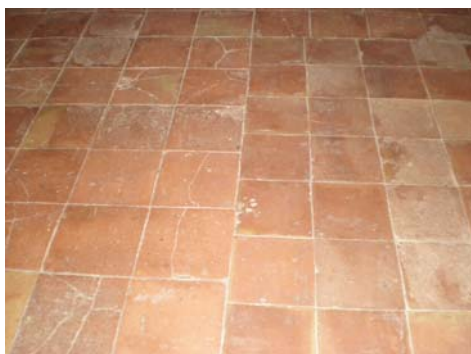
Figura 2.64. Pavimento de baldosas de barro de 30x30cm.
