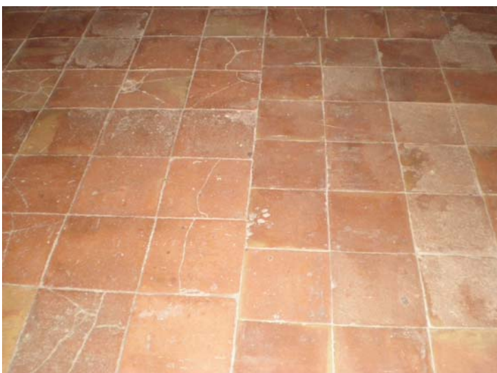
Figura 4.54. Pavimento con baldosas de barro en la sacristía
