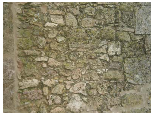
Figura 2.13. Mampostería careada en la fachada Sur.
