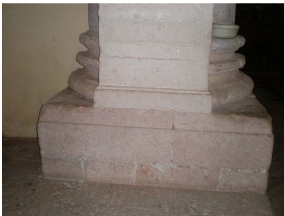
Figura 4.57. Base de las columnas del interior (perfil).
