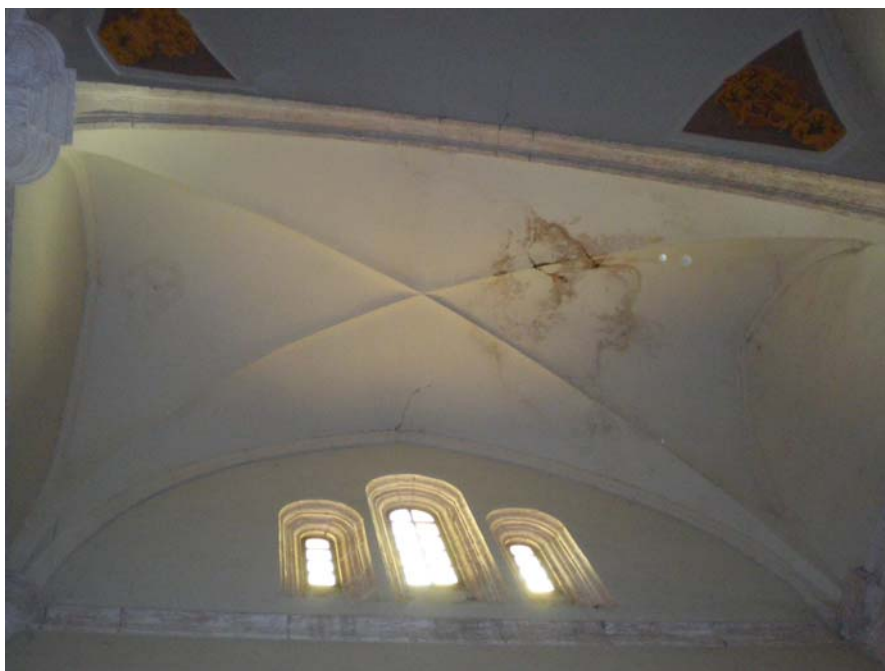
Figura 4.28. Bóveda aristada del lado Sur del crucero.
