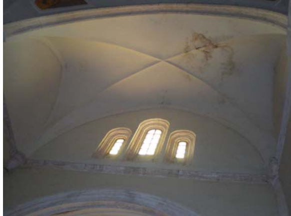
Figura 2.55. Bóveda aristada del lado Sur del crucero.
