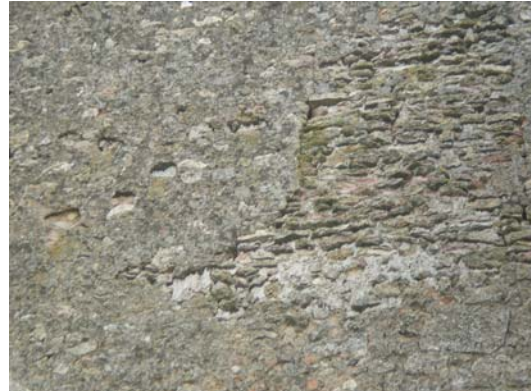
Figura 2.11. Fábrica de mampostería ordinaria en la fachada Oeste.
