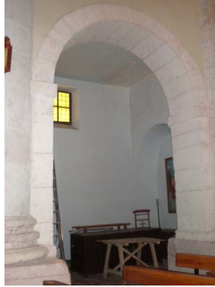
Figura 2.34. Arco de medio punto en la dependencia anexa al lado Norte del transepto
