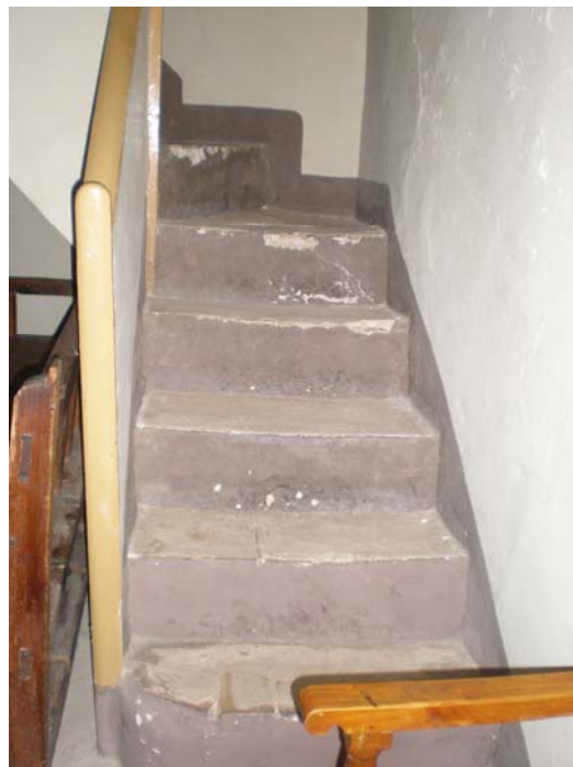
Figura 4.17. Escalera de acceso al coro.
