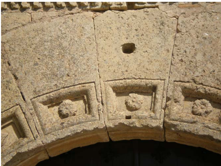
Figura 4.45. Detalle de las dovelas de la portada principal.
