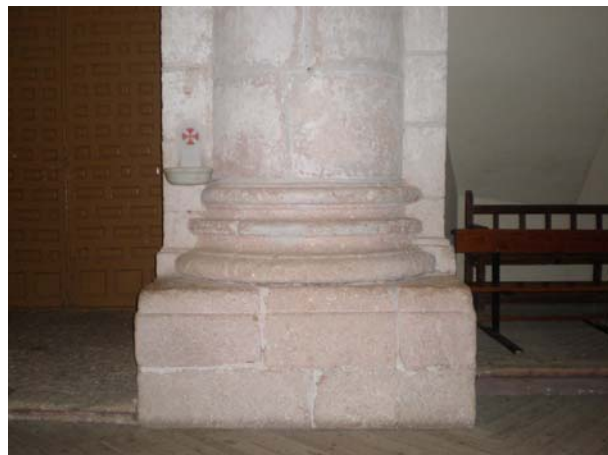
Figura 2.17. Sillería aplantillada en una de las columnas.
