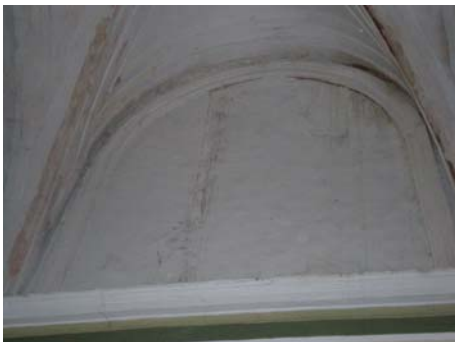
Figura 3.56. Ensuciamiento inorgánico en la capilla del extremo Sur del transepto.
