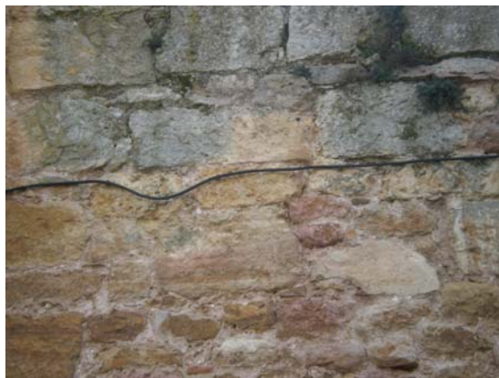
Figura 2.14. Mampostería careada en la fachada Norte.
