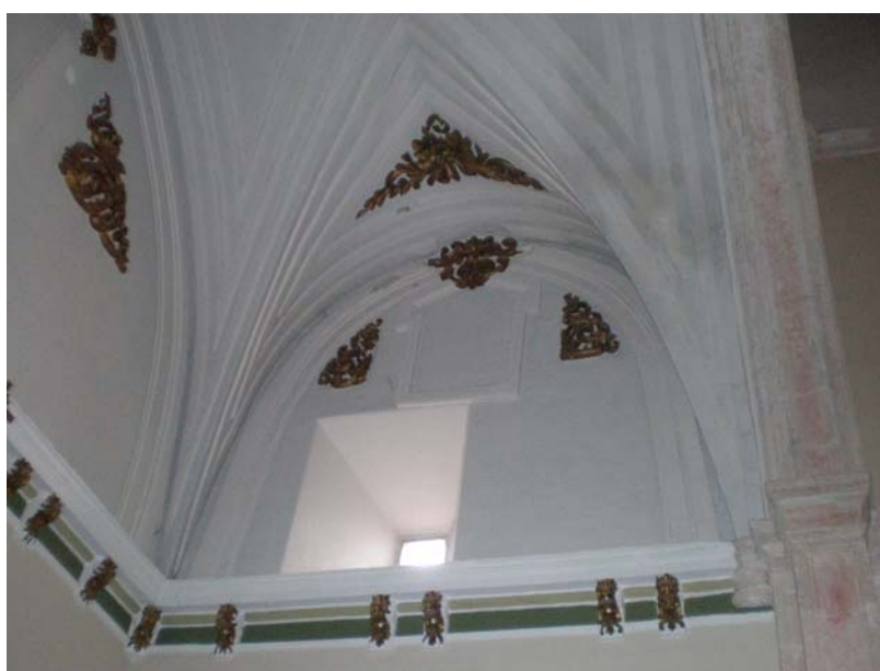
Figura 4.62. Iluminación de la capilla del extremo Norte del transepto y decoración de la misma.
