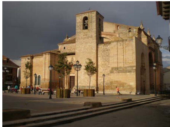
Figura 2.5. Vista de la fachada Norte (principal) de la Iglesia parroquial de San Blas.
