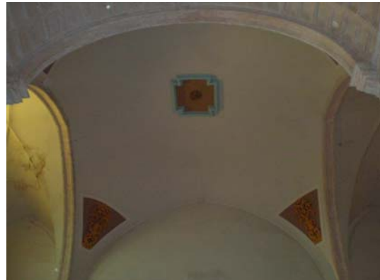
Figura 2.58. Bóveda vaída que cubre al crucero.
