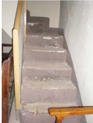
Figura 2.43. Primer tramo de la escalera de acceso al altílo.
