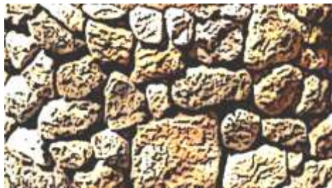
Figura 20. Mampuesto ordinaria. Fuente: elaboración propia
