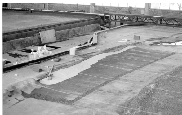
Figura 4. Ensayo con protección (Filtro)
