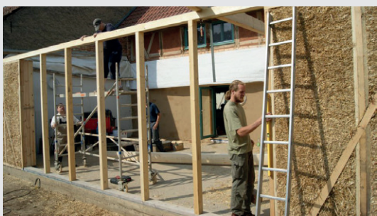
Imagen 71: Construcción de vivienda con balas de paja, siguiendo el código de construcción de Alemania
