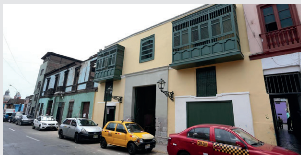
Imagen 80: Casona en Barrios Altos, Lima. La fachada está restaurada pero el interior no ha recibido ningún mantenimiento.
