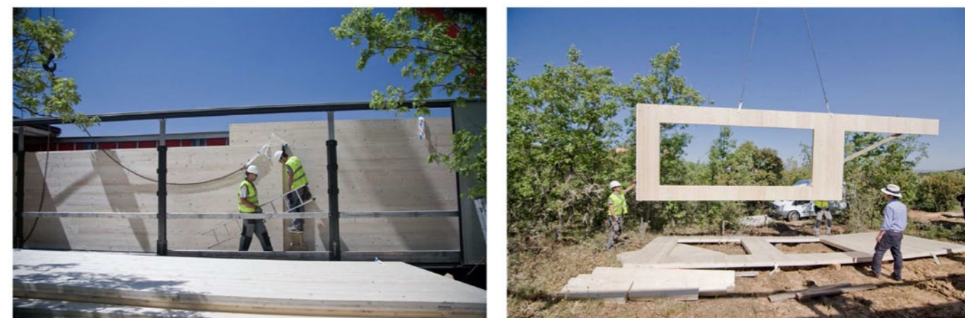
Construcción de la Casa Ex con tableros contralaminados.
