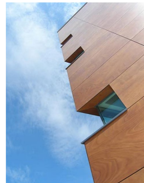
Paneles estratificados de madera de alta densidad para exteriores
