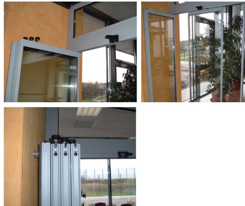
Carpintería plegable para los huecos que abren a la terraza principal en alojamientos, así como en el Balneario y permiten el paso libre en el 100% de la superficie del hueco.
